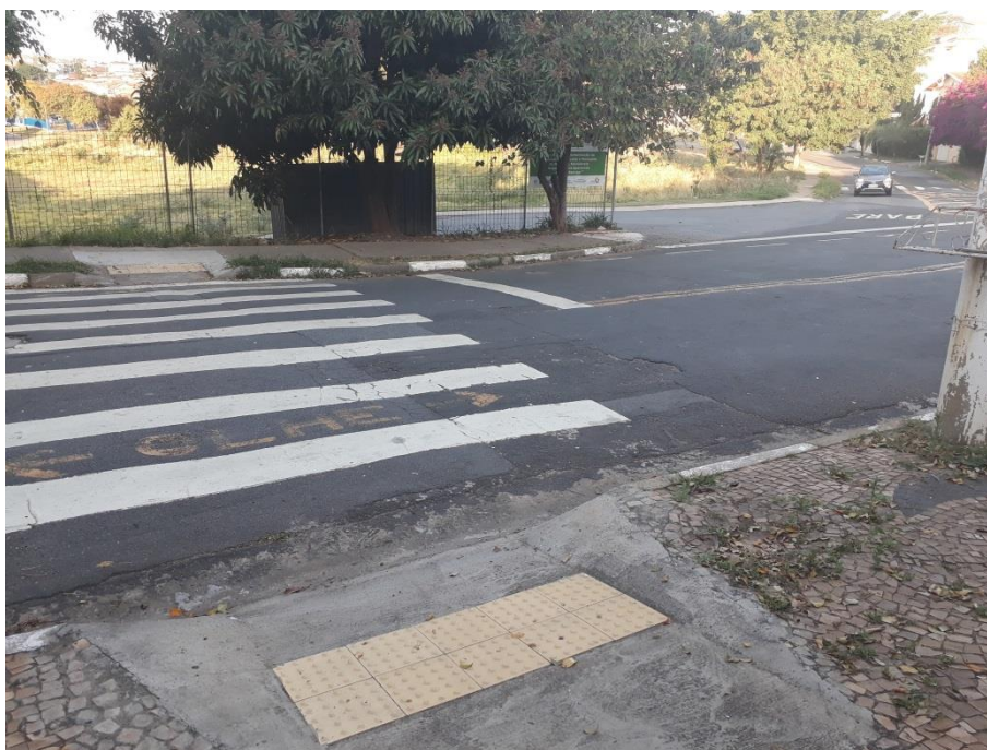
Figura 20 - Foto de rampa de acessibilidade na Foto da Rua Alaíde Nascimento de Lemos
