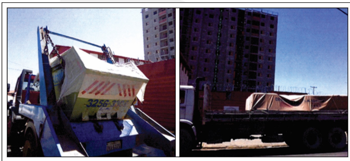
Figura 18. Exemplos de “lonamento” em caçamba de entulho e caminhão. Fonte: Global Vias.
