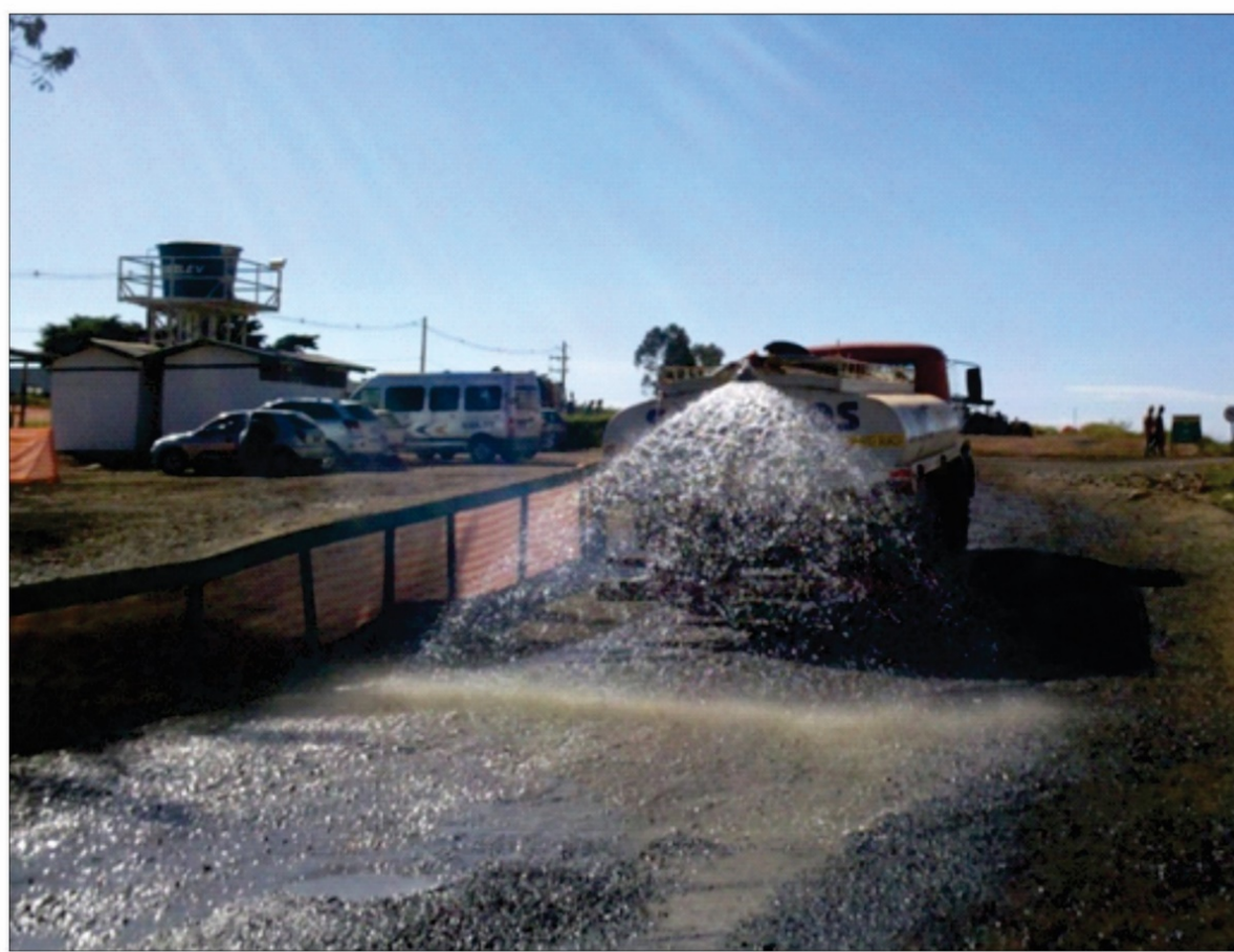
Figura 17. Exemplo de umidificação de solo na obra. Fonte: Global Vias
