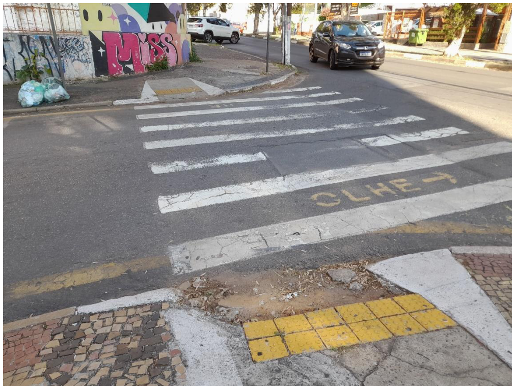
Figura 12. Vista da faixa de pedestre com acessibilidade para cadeirantes na Avenida Francisco Glicério.
