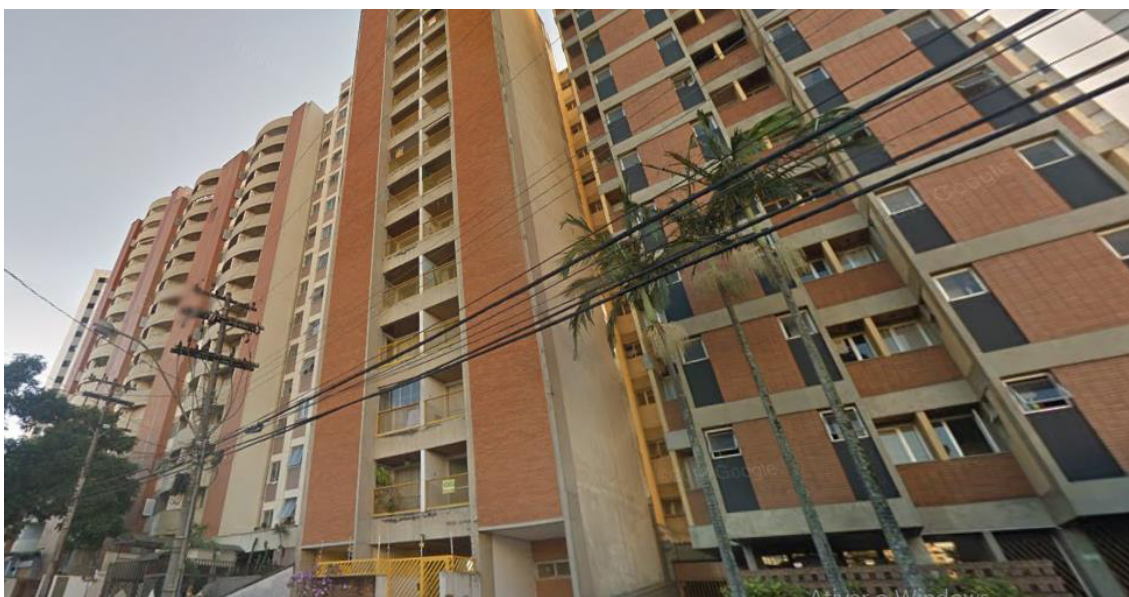
Figura 20. Residencial multifamiliar localizado na Área de Influência Indireta.
