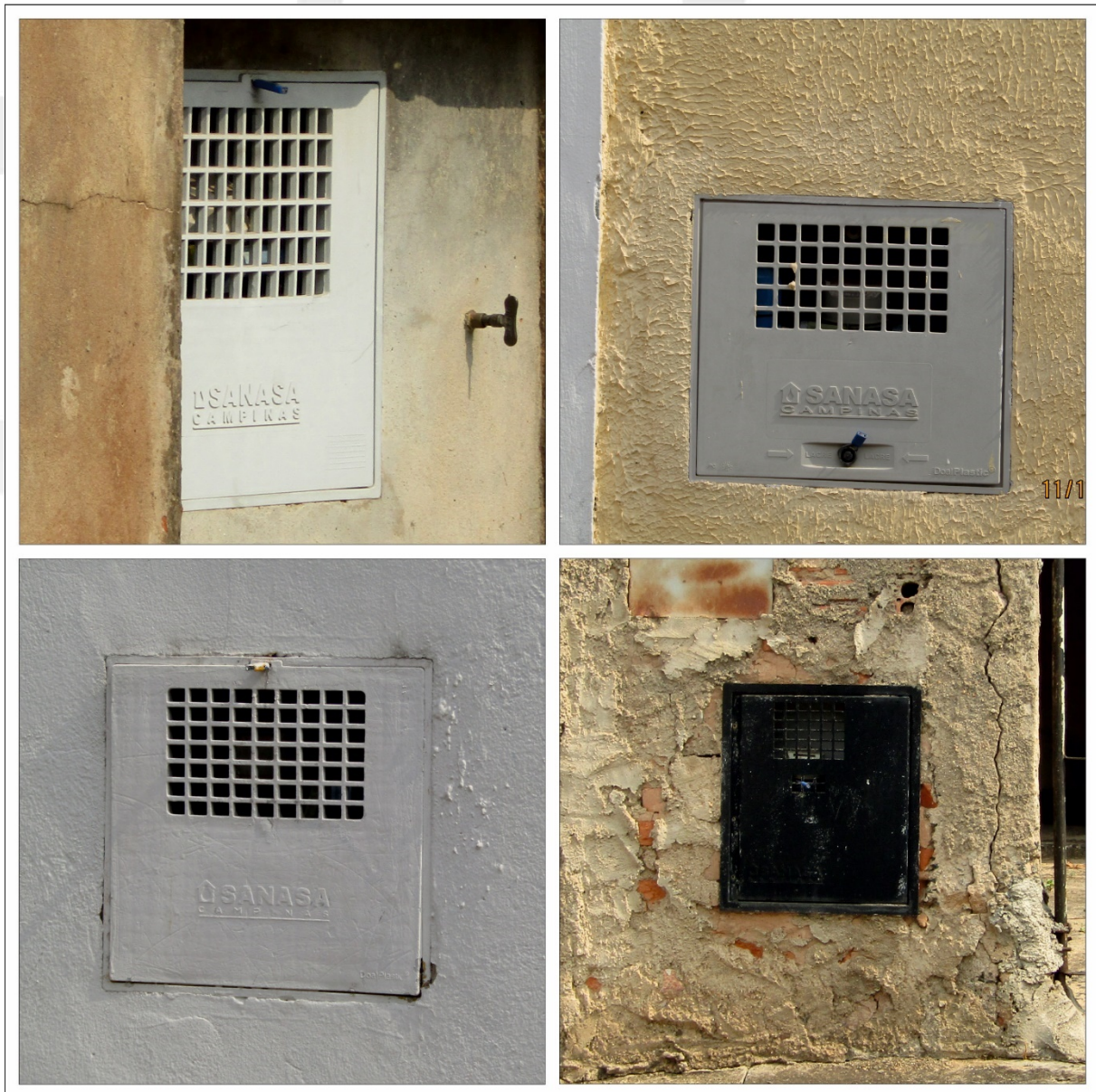
Figura 29. Fotografias – medidores de água.
