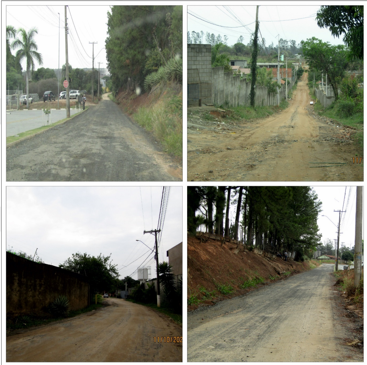
Figura 33. Fotografias – via de acesso do empreendimento. Fonte: Elaborado por Global Vias.
