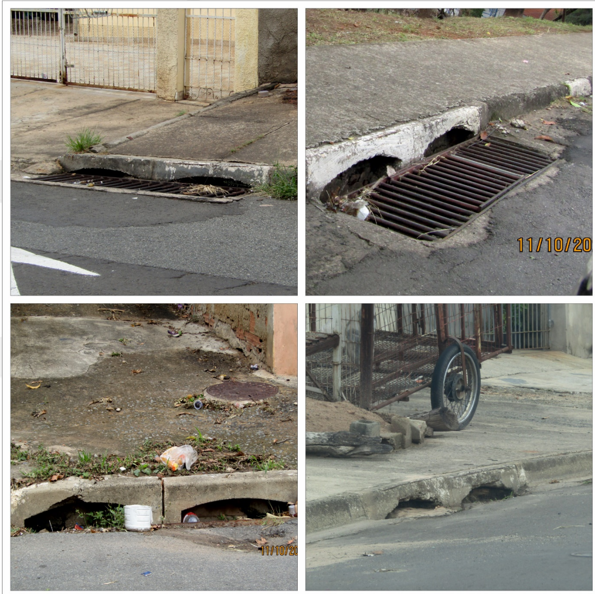
Figura 32. Fotografias – dispositivos de boca de lobo.
