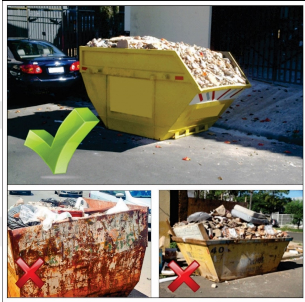
Figura 27. Modelo de acondicionamento de resíduos em caçambas.
