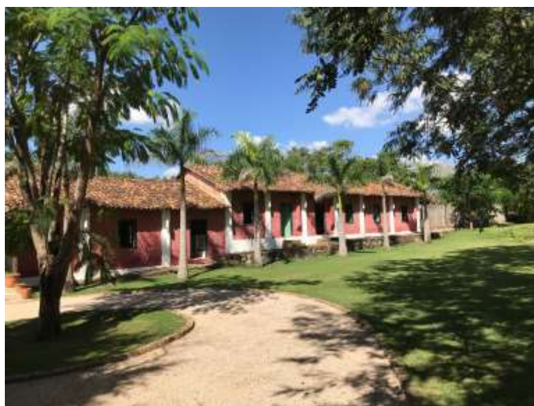
Foto 3: Edificação Objeto do Alvará.
