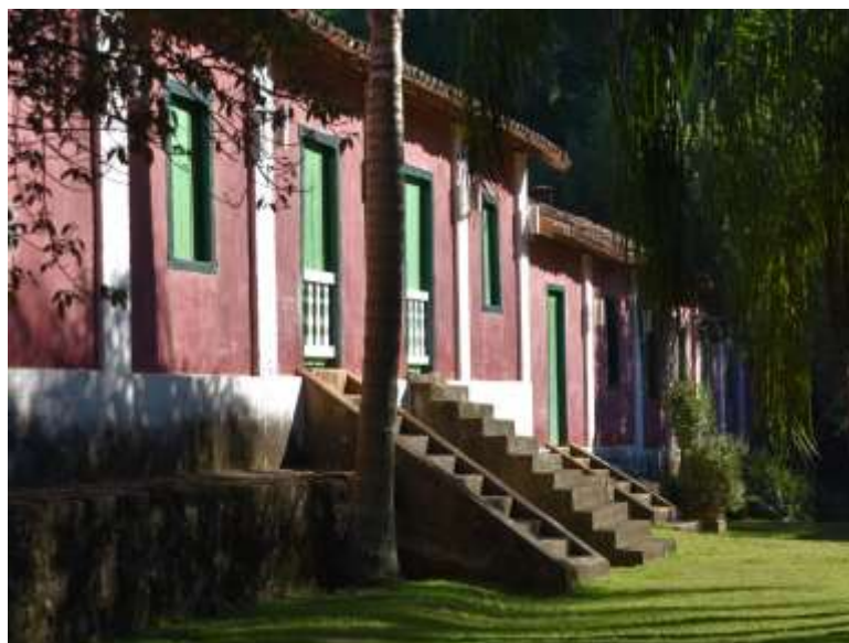
Foto 2: Edificação Objeto do Alvará.
