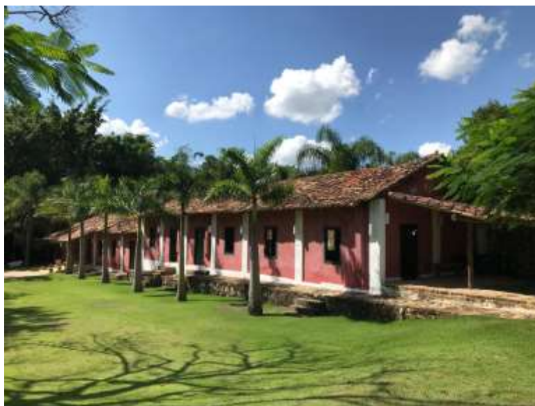
Foto 1: Edificação Objeto do Alvará.
