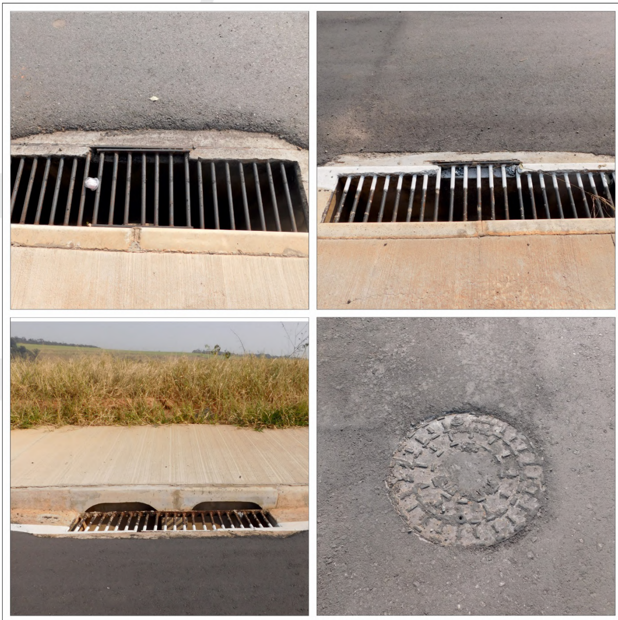
Figura 31. Fotografias – Rede de drenagem pluvial da região do empreendimento Elaborado por Global Vias.
