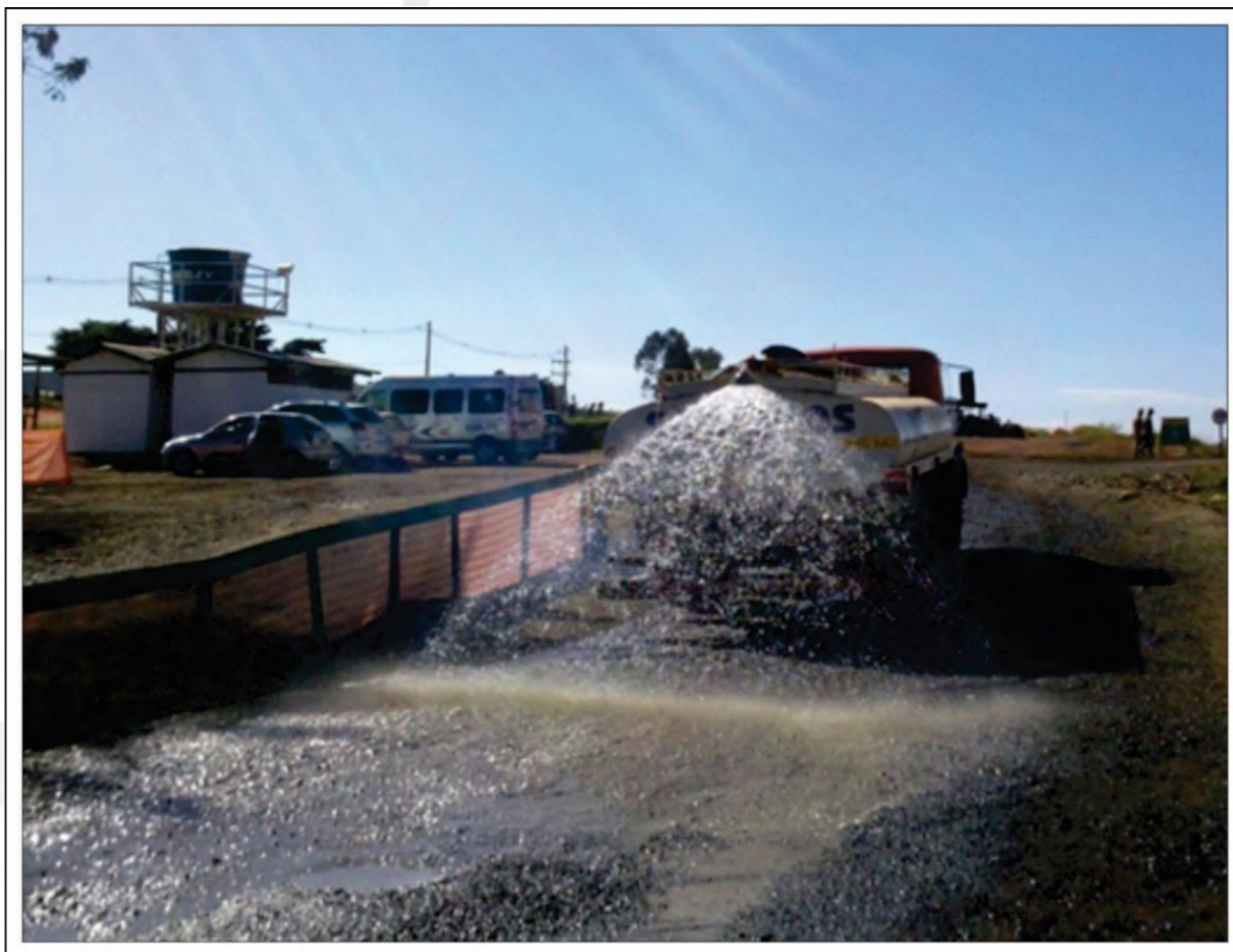
Figura 22. Exemplo de umidificação de solo na obra. Fonte: Global Vias.
