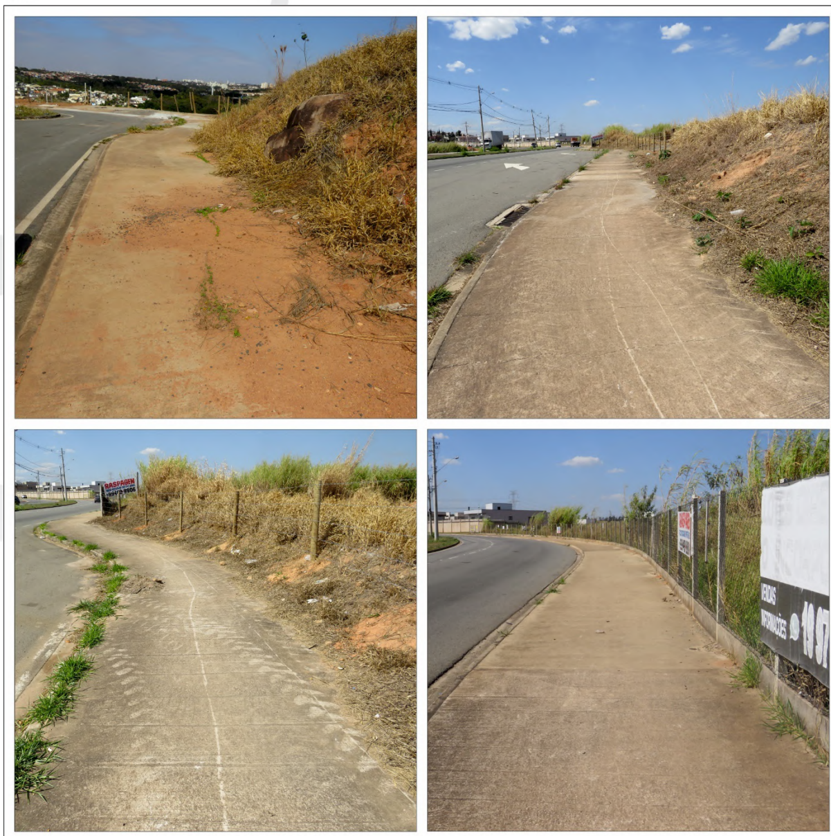
Figura 32. Fotografias - Calçadas no entorno do empreendimento
