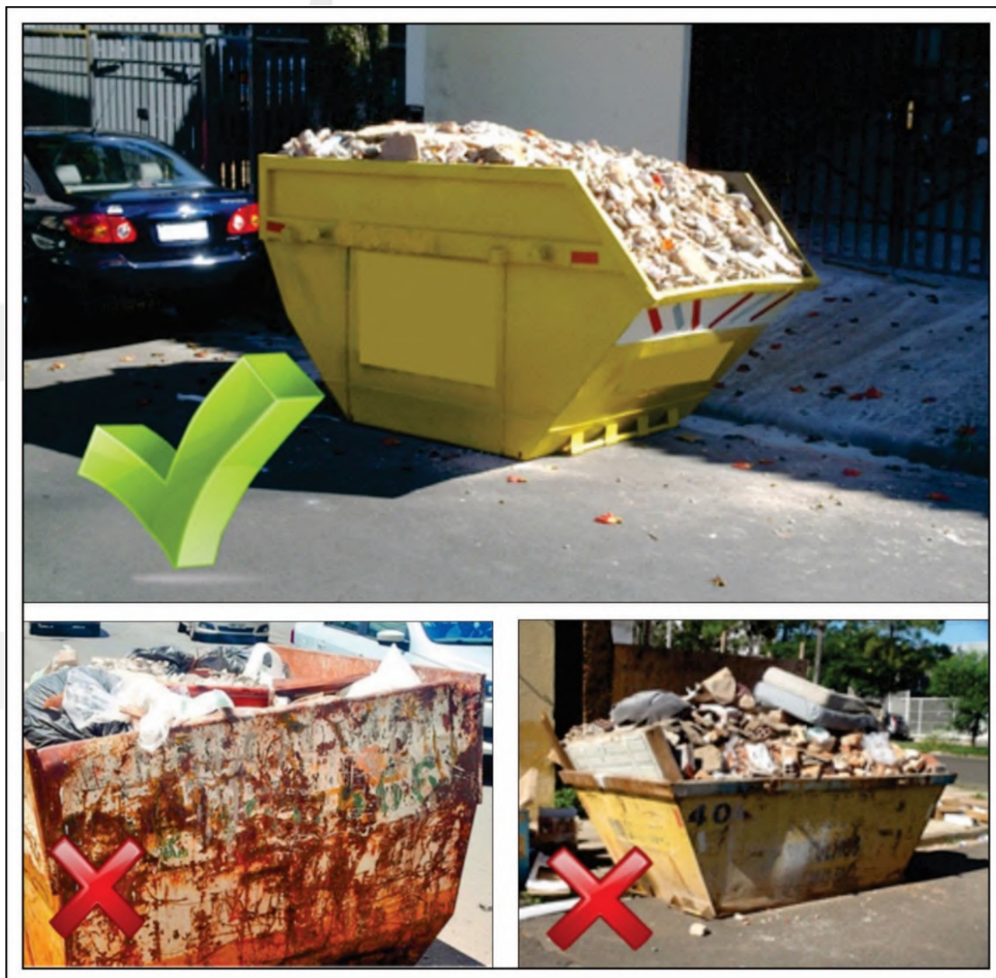
Figura 26. Modelo de acondicionamento de resíduos em caçambas
