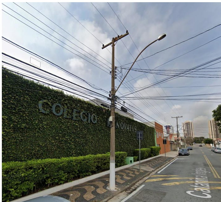
Figura 18 Iluminação Pública Existente Rua Catarina Inglese Soares
