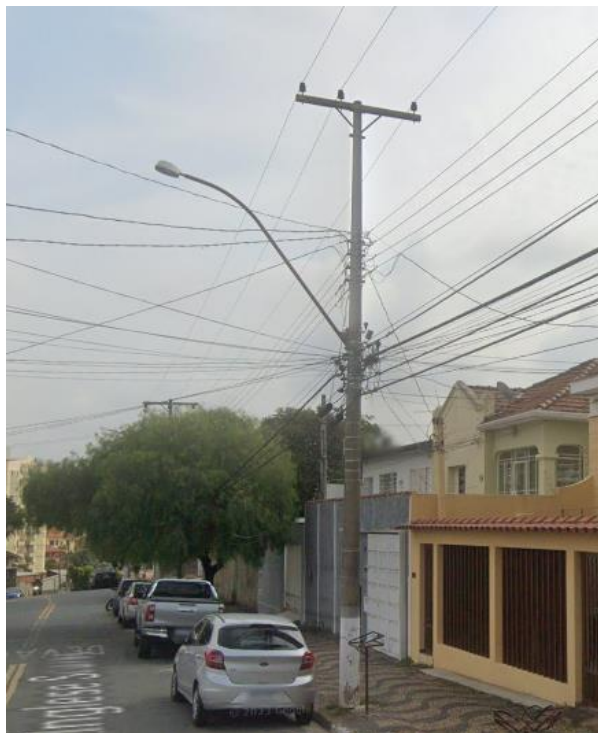
Figura 19 Iluminação Pública Existente na Rua Catarina Inglese Soares
