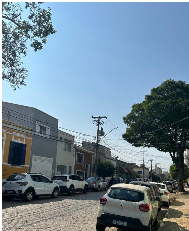
Figura 17 Iluminação Pública Existente na Rua 24 de Maio
