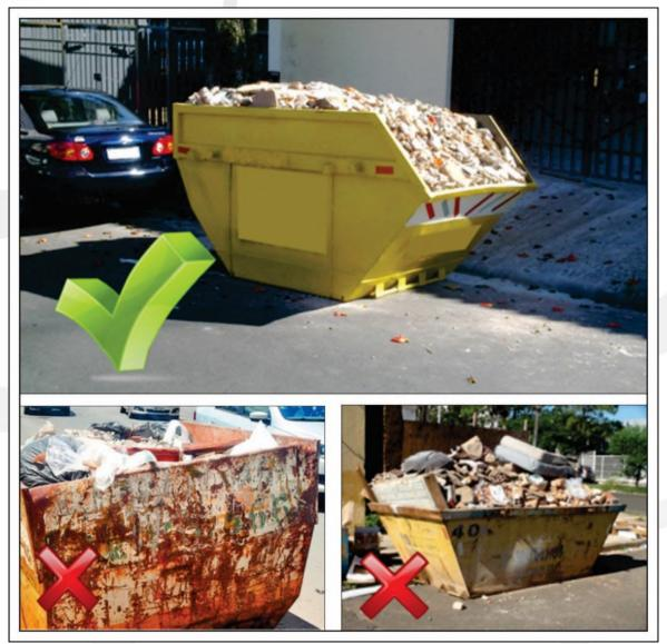
Figura 19. Modelo de acondicionamento de resíduos em caçambas
