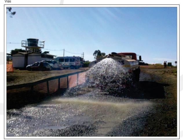
Figura 15. Exemplo de umidificação de solo na obra.
