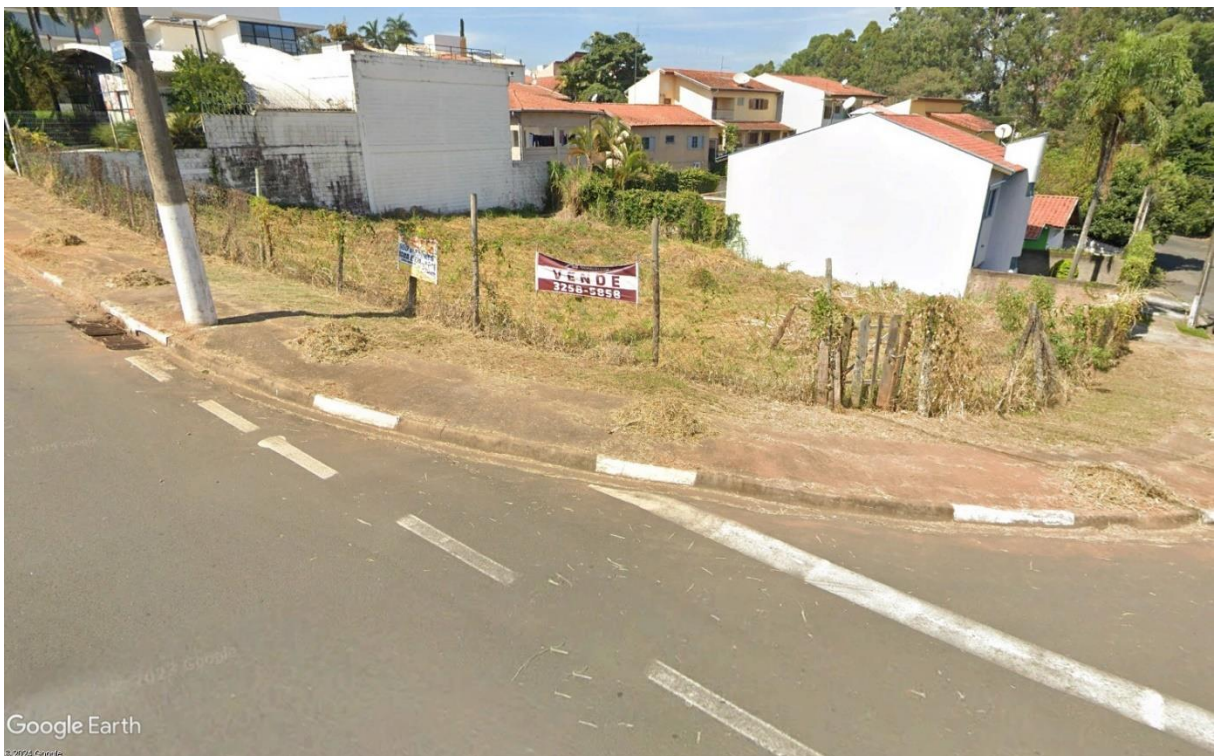
Figura 11 – Situação atual do empreendimento (Fonte: Google Earth – Julho/2024)
