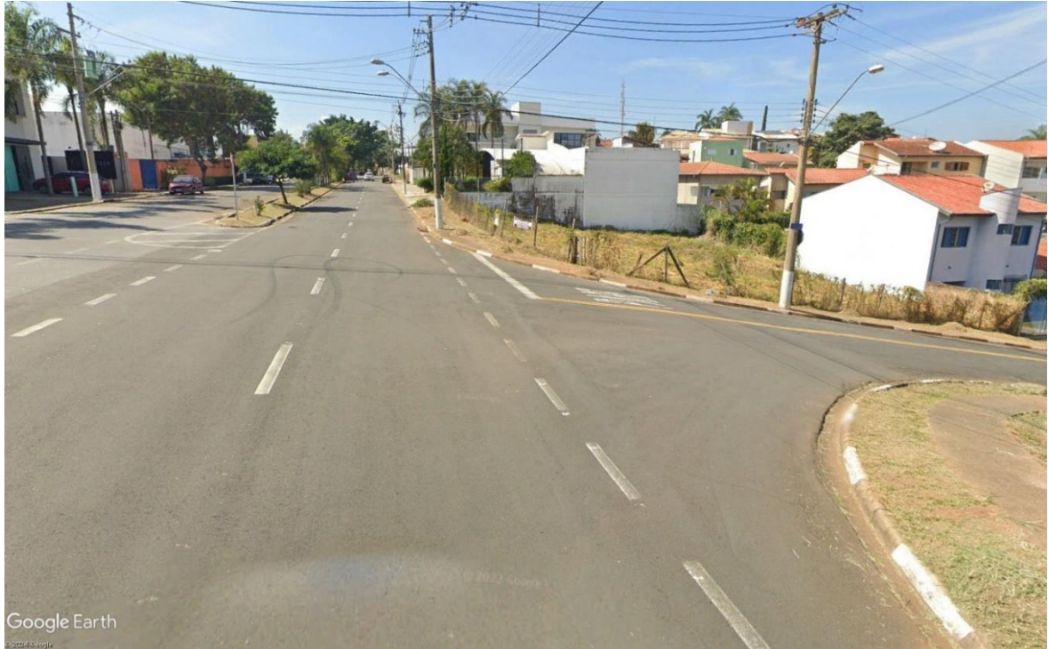
Figura 8.1 - Vista da Av. Dona Júlia Conceição Alves (esquerda) e Rua Rosa Aburad Khouri (direita) (Fonte: Google Earth – Julho de 2024).
