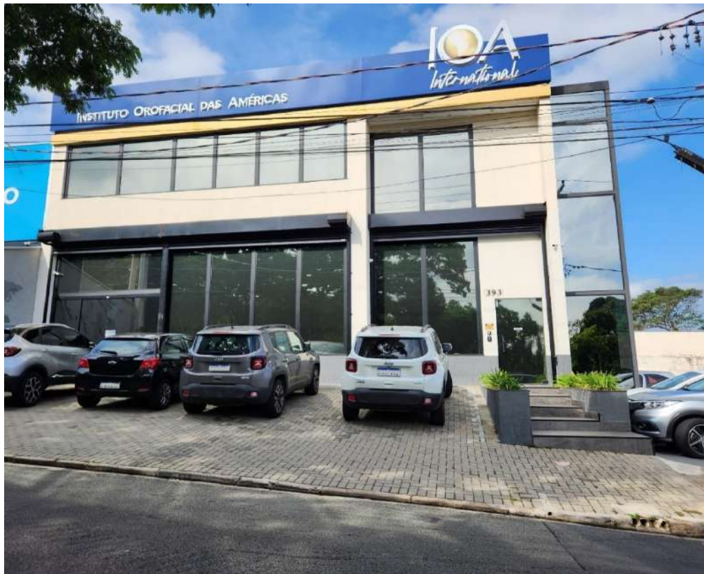
Figura 1. Fachada do Empreendimento Fonte: A.S. Consultoria e Engenharia
