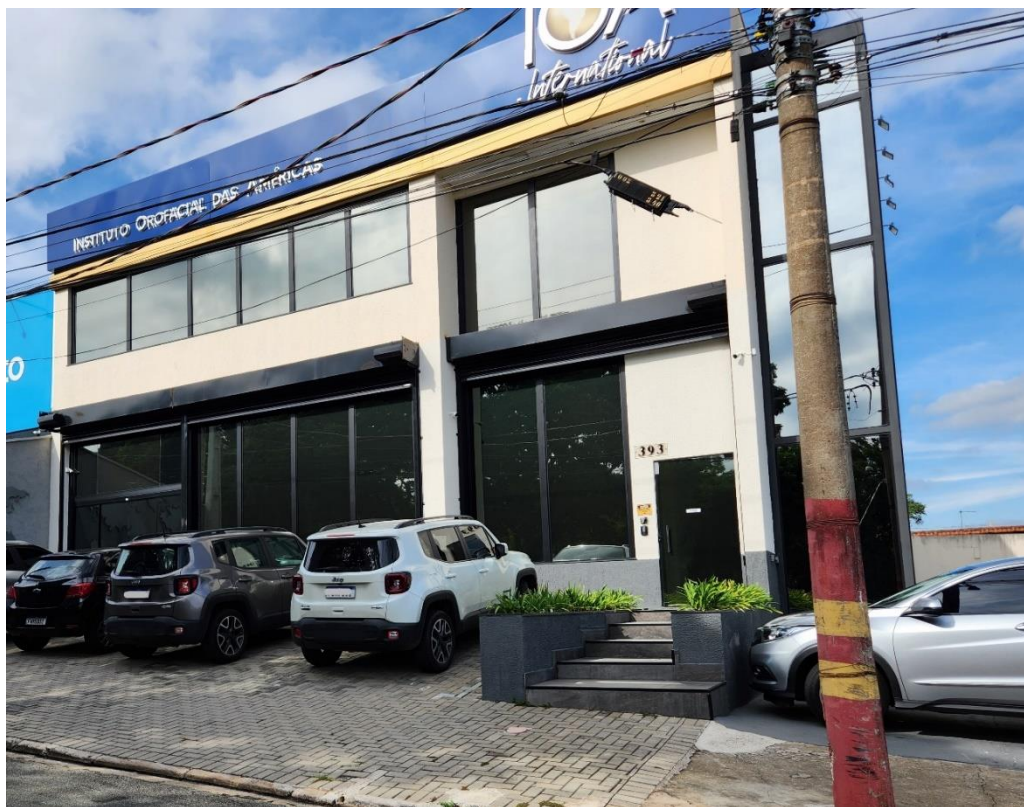
Figura 2. Empreendimento Fonte: A.S. Consultoria e Engenharia
