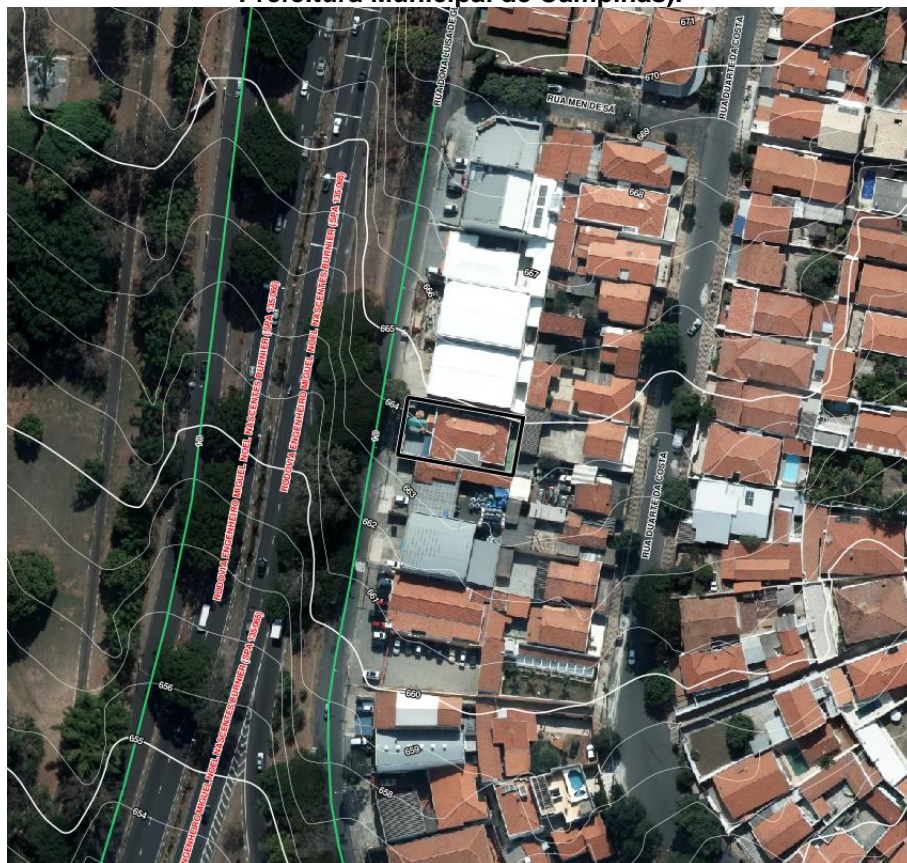
Figura 5 - Ortofotografia do local do empreendimento em Campinas - Lote 22 - Jul/2014 (Fonte: Prefeitura Municipal de Campinas).
