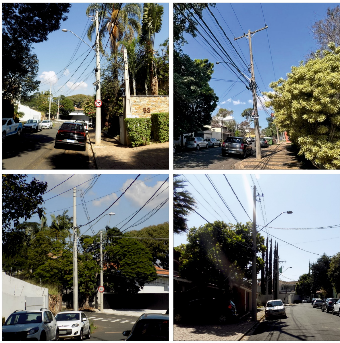
Figura 19. Fotografias – Postes de iluminação pública Fonte: Google Earth – Modificado por Global Vias.
