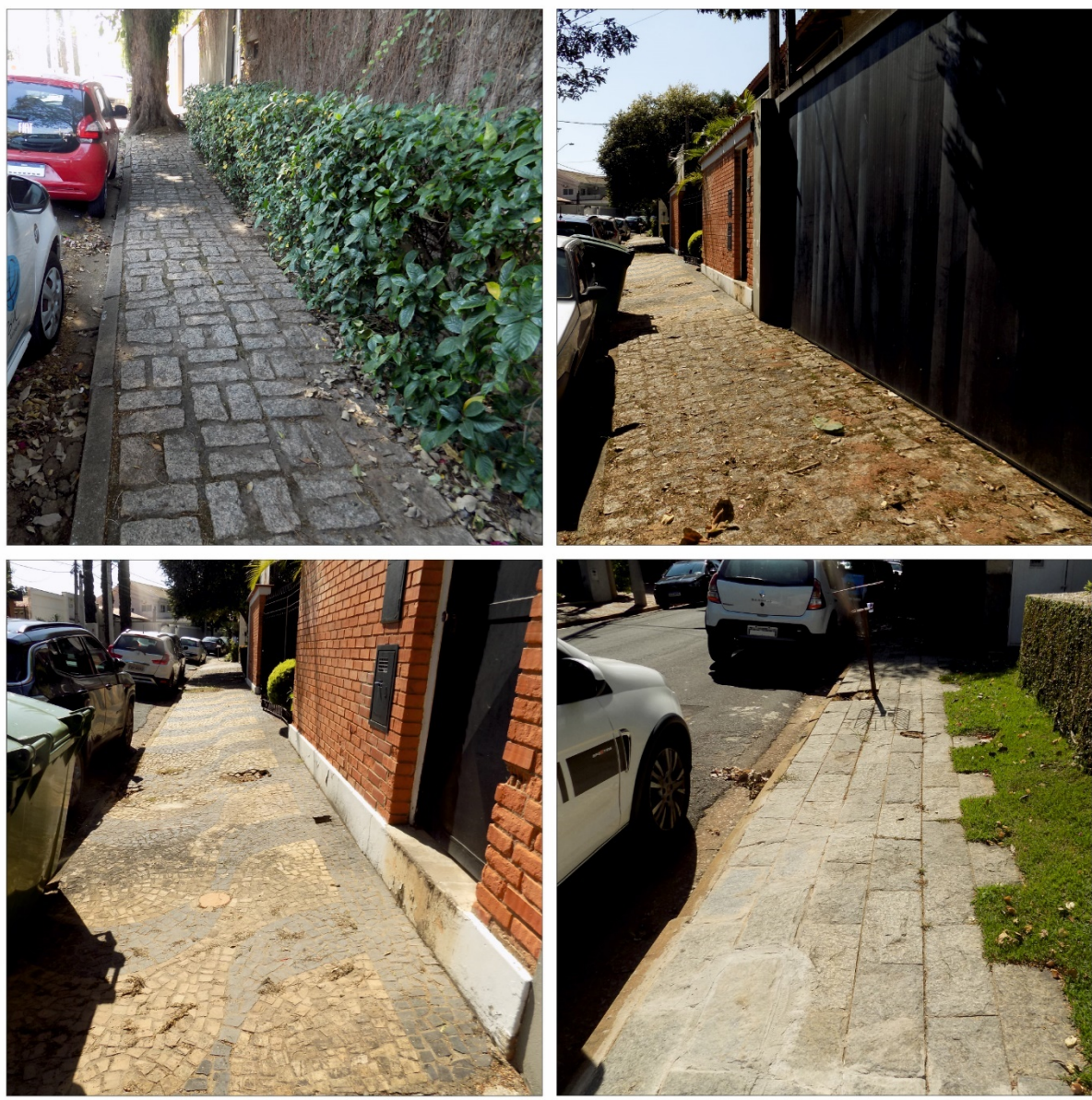
Figura 22. Fotografias – Calçadas no entorno do empreendimento.
