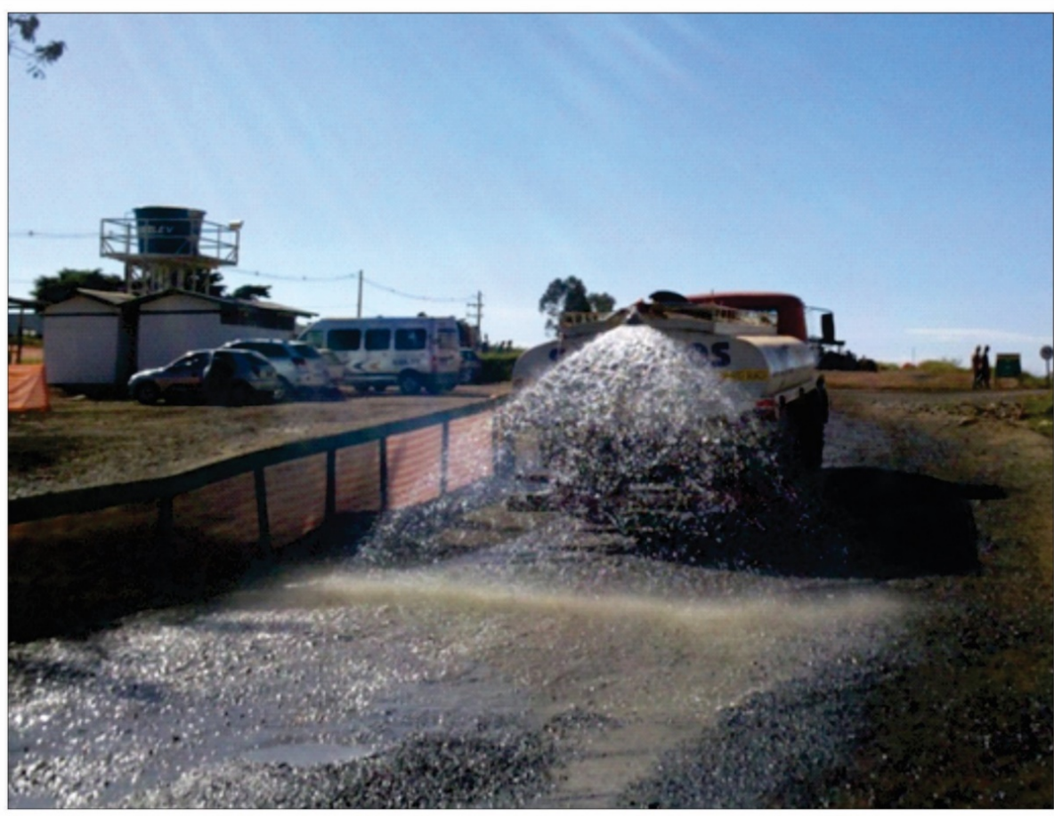
Figura 11. Exemplo de umidificação de solo na obra. Fonte: Global Vias
