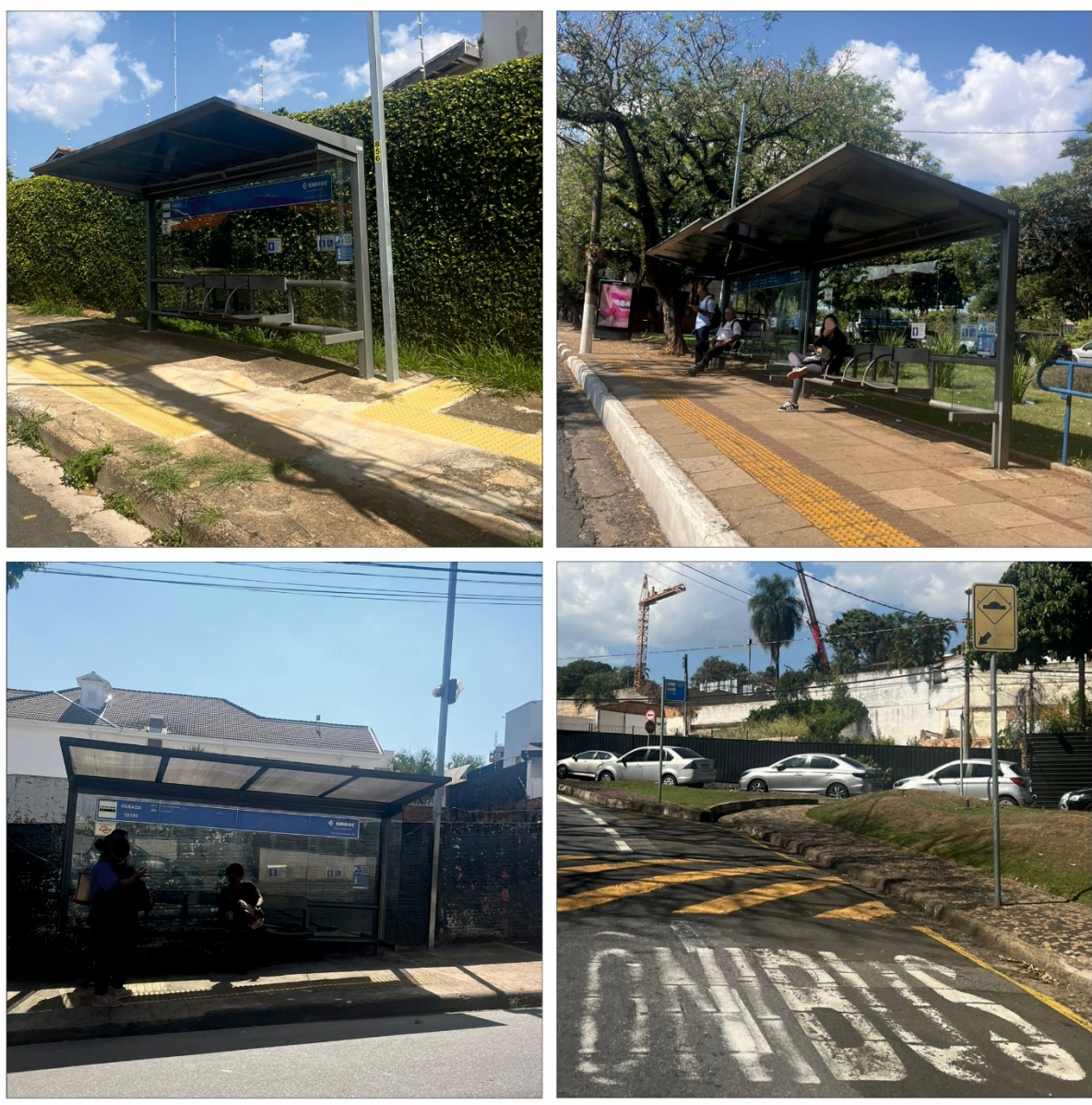
Figura 25. Fotografias - Condições dos pontos de ônibus localizados.
