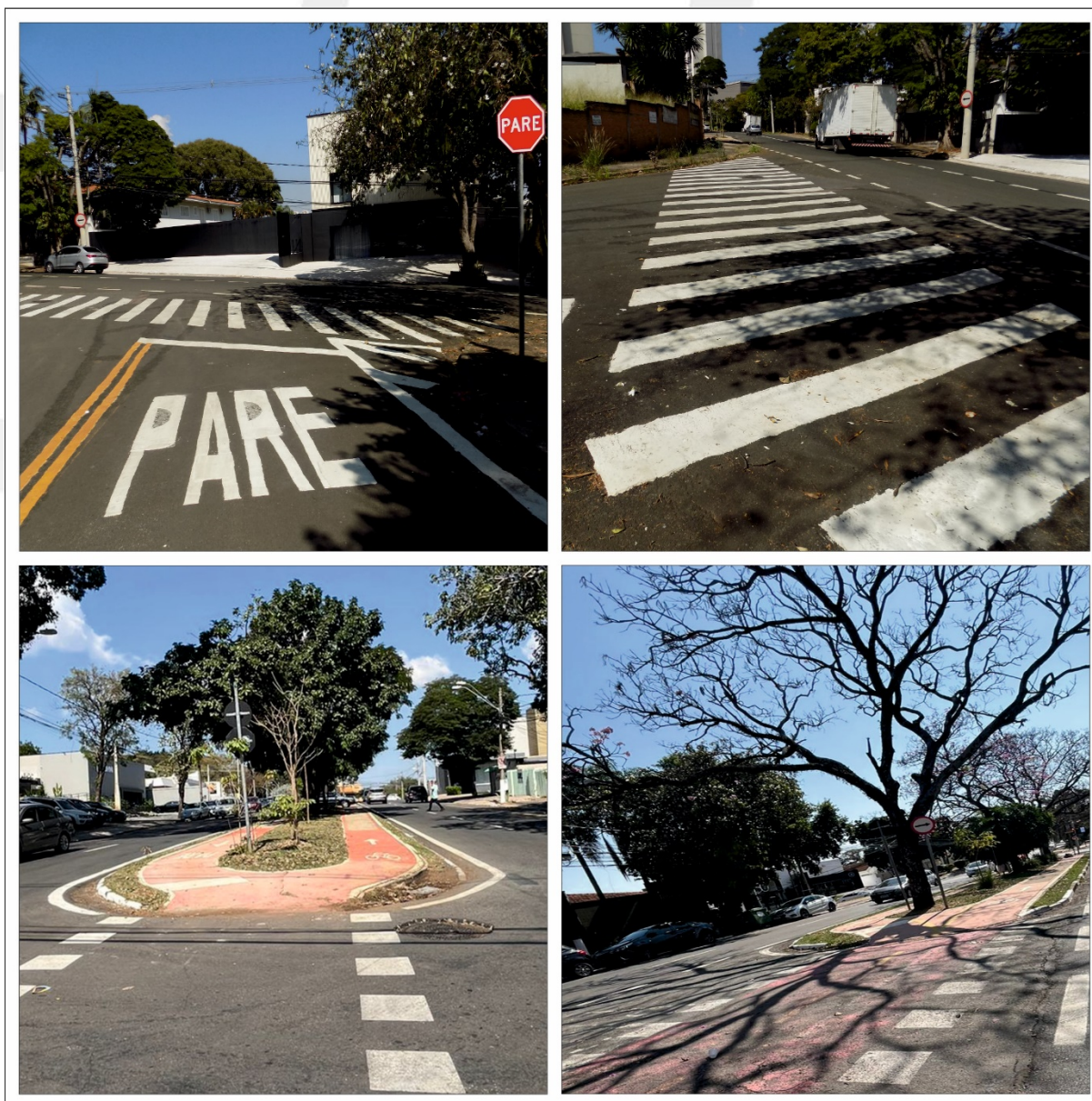
Figura 23. Fotografias – Dispositivos de caminhabilidade no entorno do empreendimento. Fonte: Elaborado por Global Vias.
