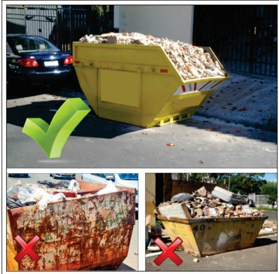
Figura 24. Modelo de acondicionamento de resíduos em caçambas.
