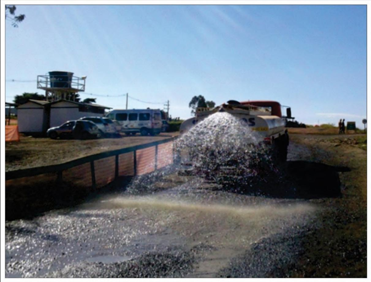
**Figura 20. Exemplo de umidificação de solo na obra.**
