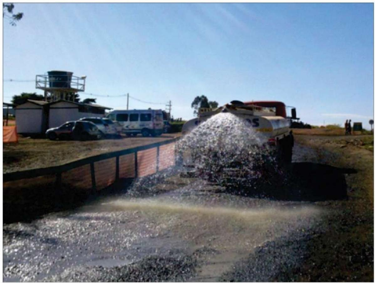
**Figura 24. Exemplo de umidificação de solo na obra.**
