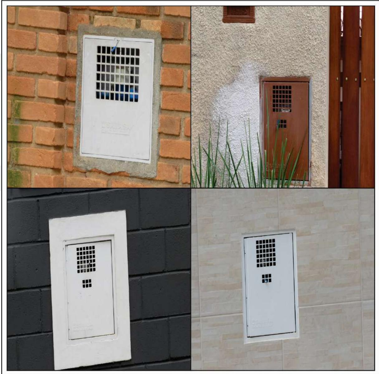
**Figura 30. Fotografias – Equipamentos medidores das redes de água e esgoto**
