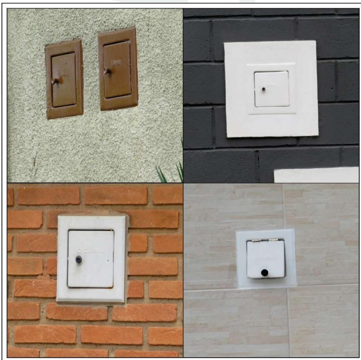
**Figura 33. Fotografias – Equipamentos medidores de energia elétrica.**
