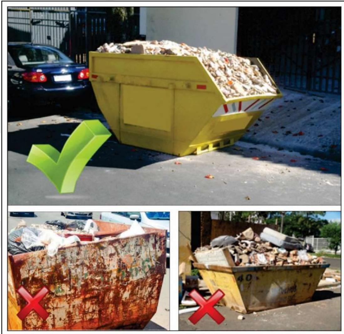
Figura 28. Modelo de acondicionamento de resíduos em caçambas
