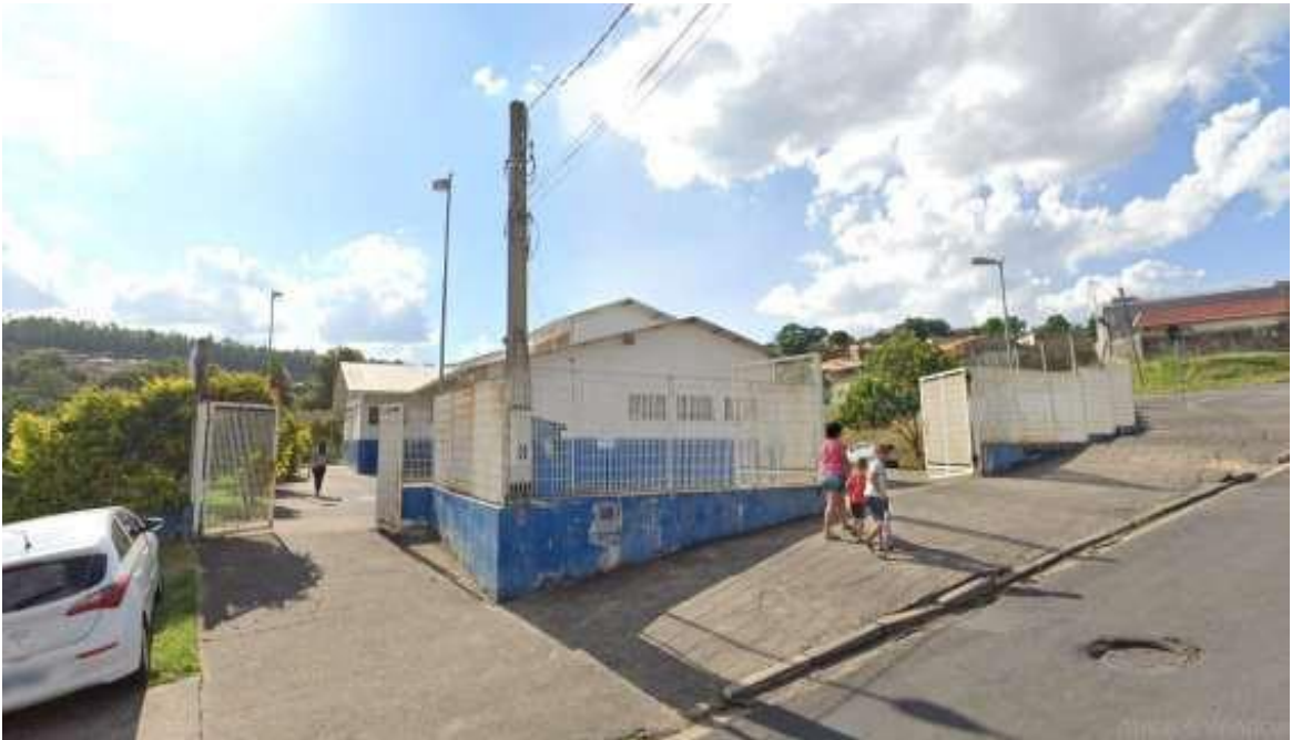
Figura 9. Centro de saúde encontrada na AI do empreendimento, classificada como área institucional.
