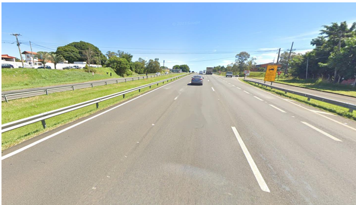
Figura 11. Vista geral da Rodovia Prof. Zeferino Vaz, com ótimas condições de pavimentação.
