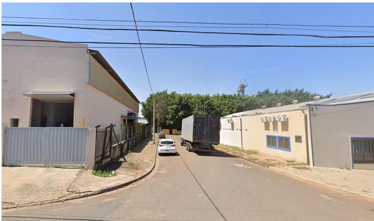
Figura 4. Vista geral da entrada e saída de veículos do empreendimento.
