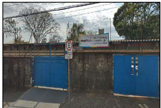
Foto 21. Escola Estadual Procopio Ferreira.
