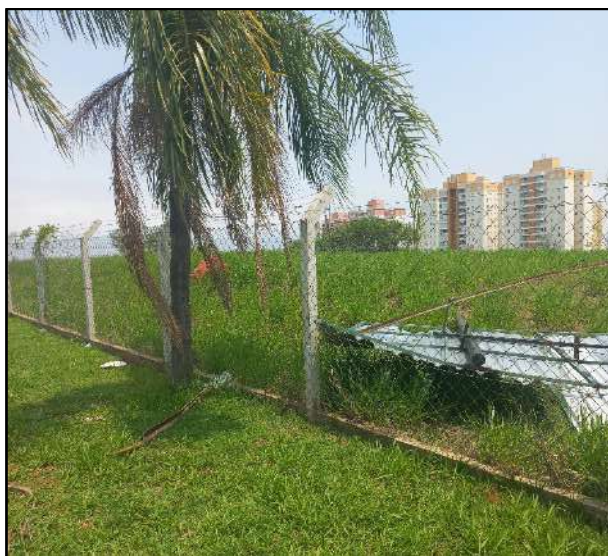
Foto 5. Vista da lateral do terreno – Lote 55F-A.
