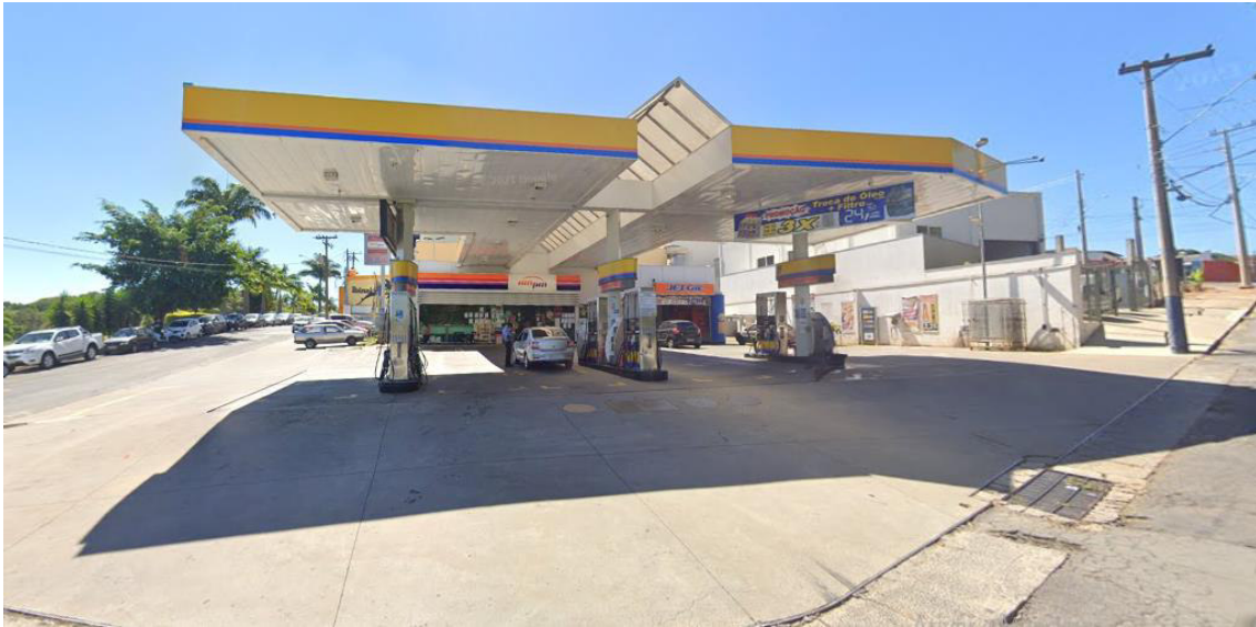
Figura 6. Uso comercial – Rua Ernesto Bristote.
