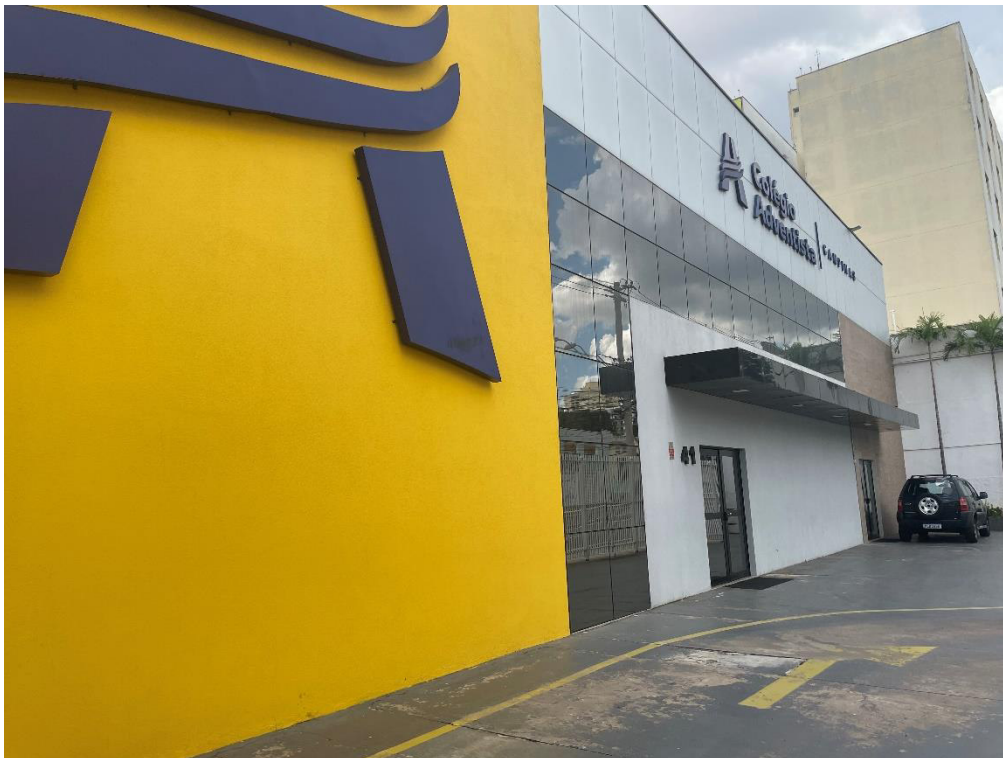
Figura 17. Vista do auditório existente no Lote 01-SUB.
