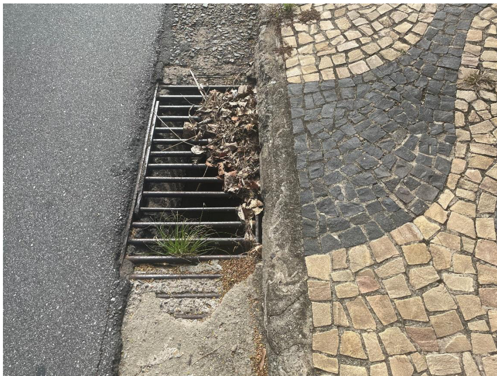
Figura 21. Vista de dispositivo de drenagem na Rua Eng. Carlos Stevenson.
