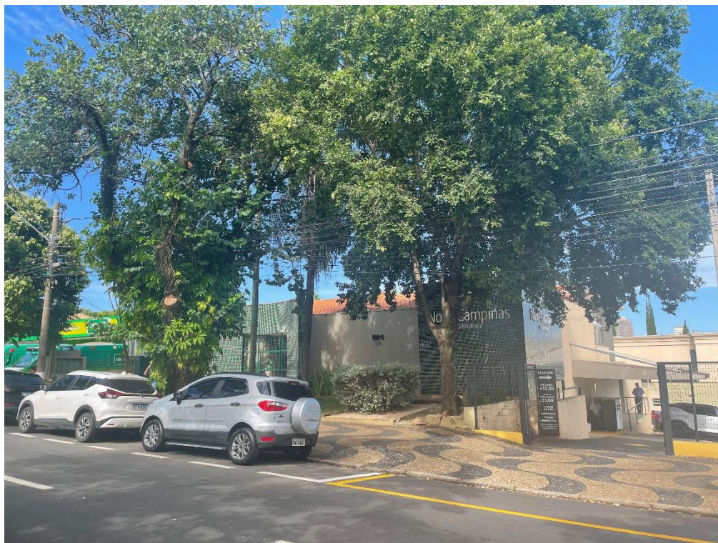
Figura 09. Vista do lote C que possui toda a edificação da clínica.
