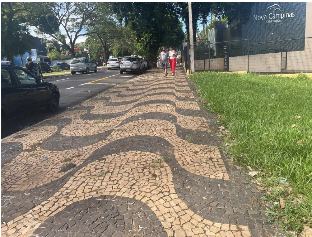
Figura 19. Vista do passeio da Av. Dr. Jesuíno Marcondes Machado.
