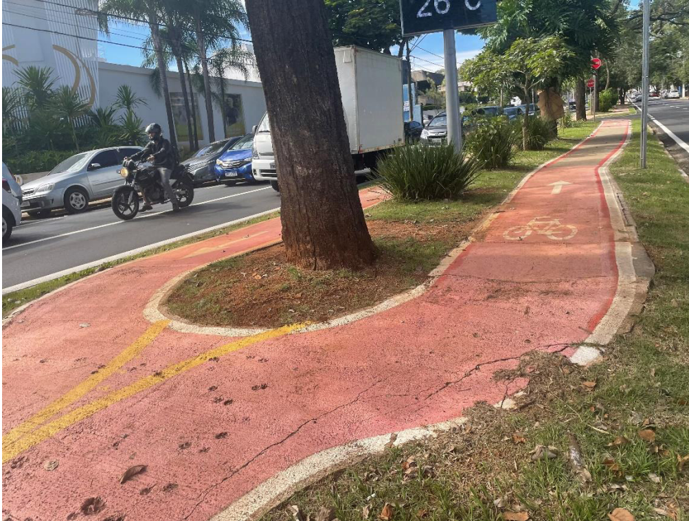
Figura 42. Vista da ciclovia na Avenida Dr. Jesuíno Marcondes Machado.
