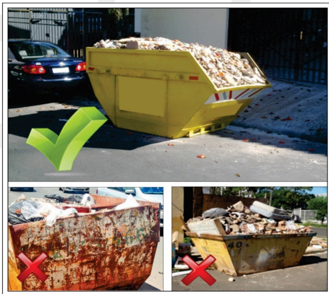
Figura 39. Modelo de acondicionamento de resíduos em caçambas.
