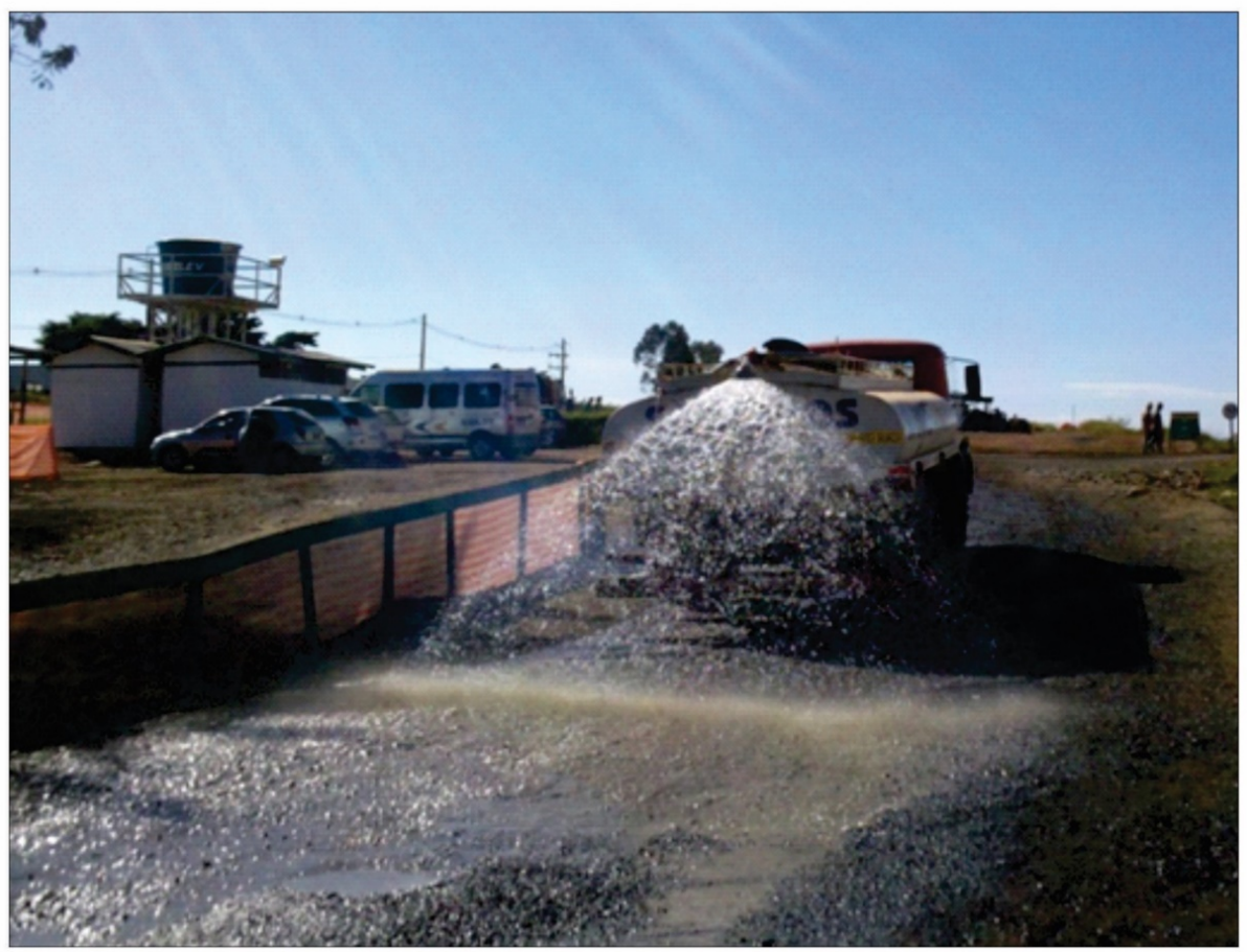
Figura 35. Exemplo de umidificação de solo na obra. Fonte: Global Vias
