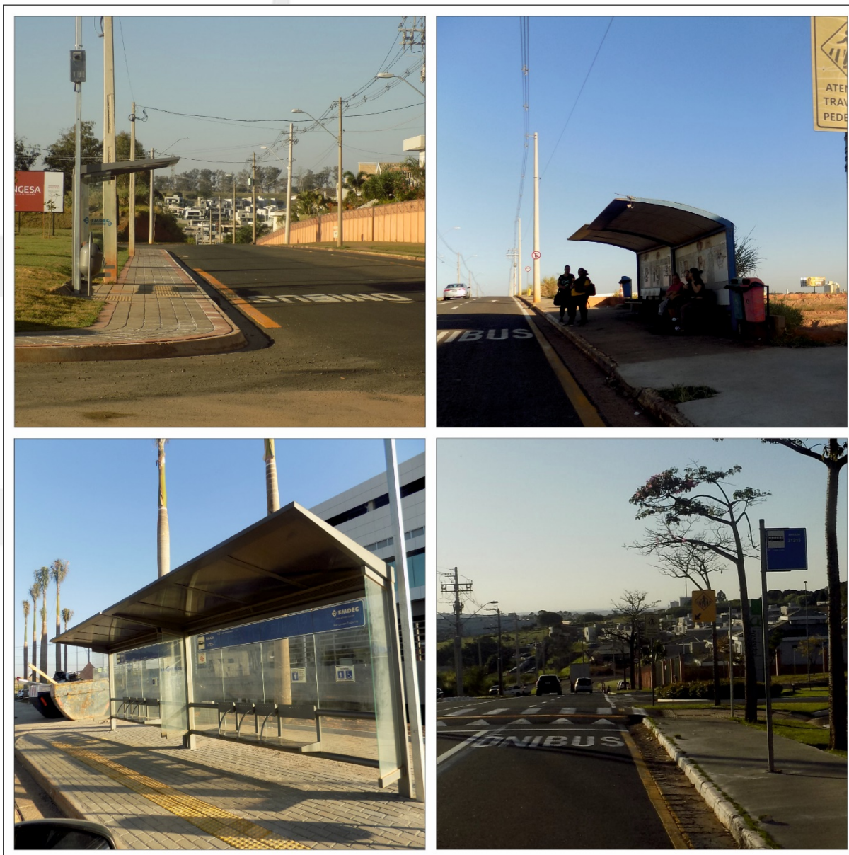
Figura 49. Fotografias - Condições dos pontos de ônibus localizados.
