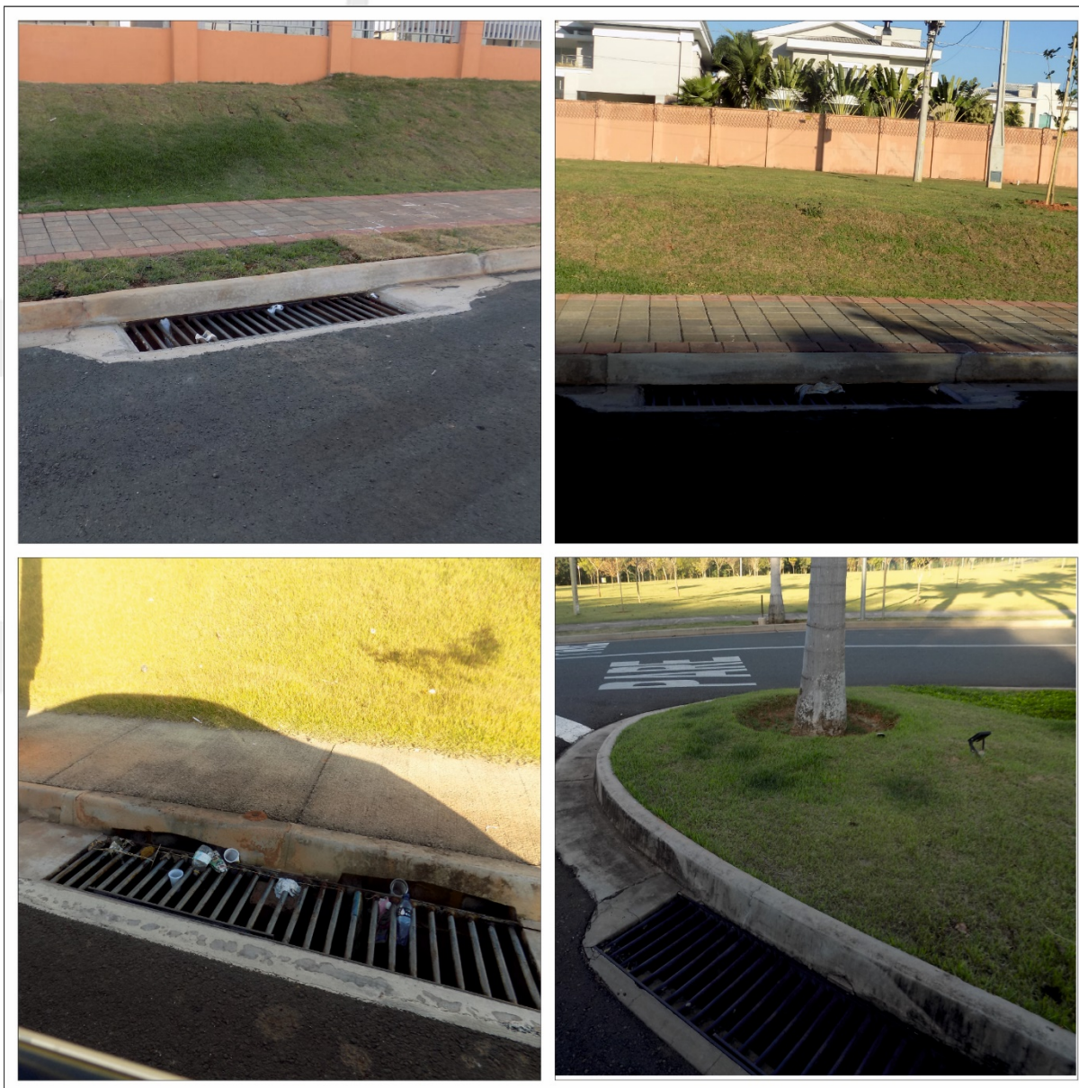
Figura 44. Fotografia - Boca de lobo. Fonte: Elaborado por Global Vias.
