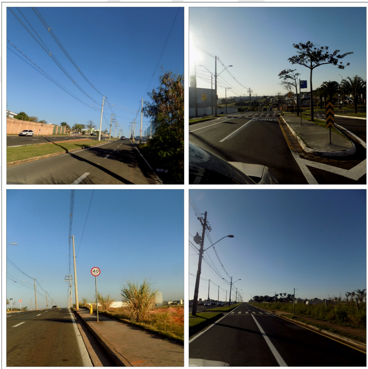
Figura 45. Fotografias – Vias no entorno do empreendimento. Fonte: Elaborado por Global Vias.
