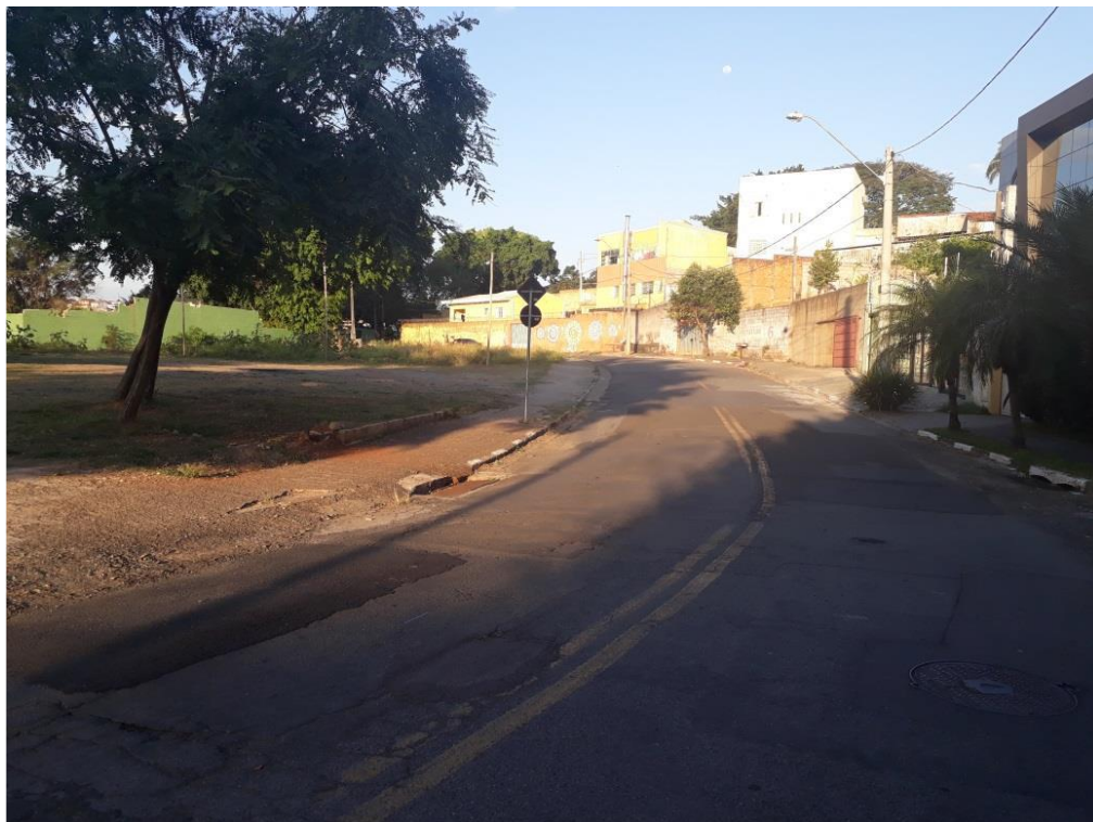
Figura 6. Foto da situação da via de acesso
