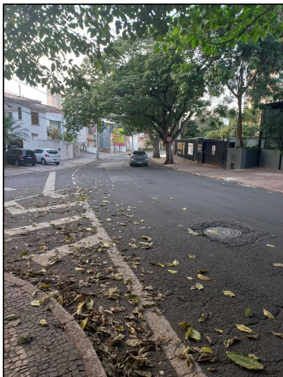
Foto 21. Rua Maria Monteiro sentido empreendimento (P1).
