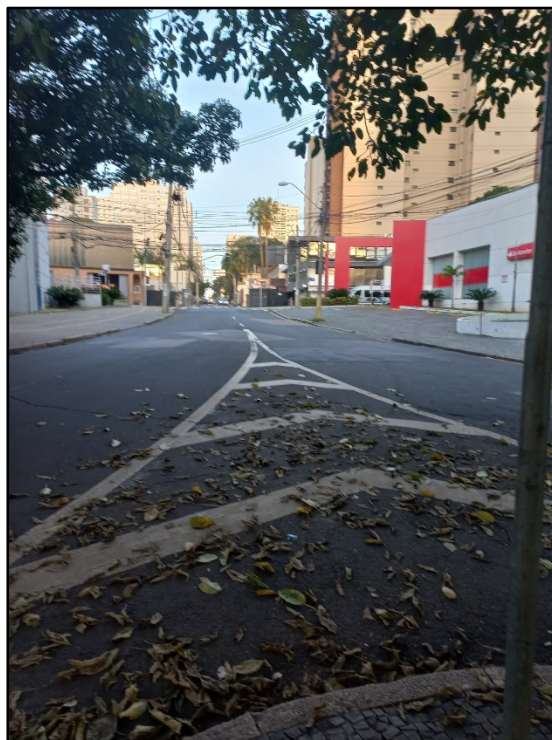
Foto 22. Rua Conceição sentido oposto ao empreendimento (P1).
