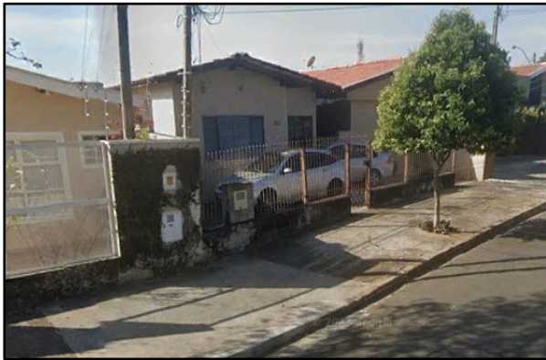
Foto 17. Residências (Norte da AI).
