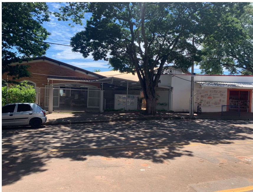
Foto 2: Fachada do Empreendimento (nº 175).
