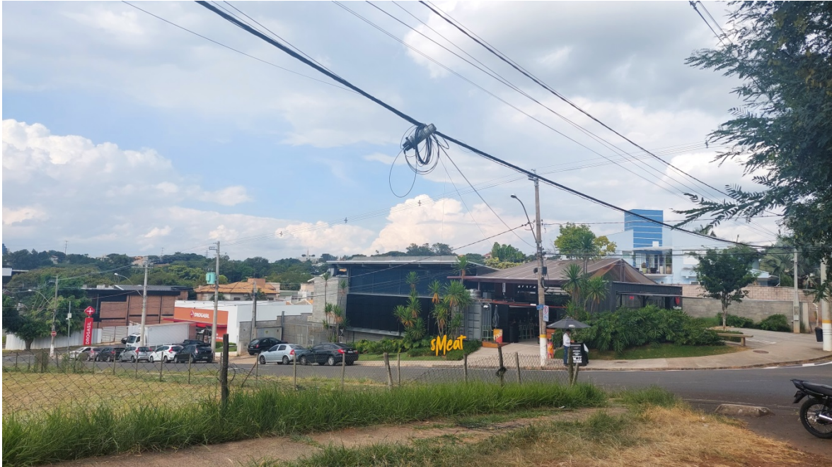
Foto 24. Rua Raul Teixeira Penteado.
