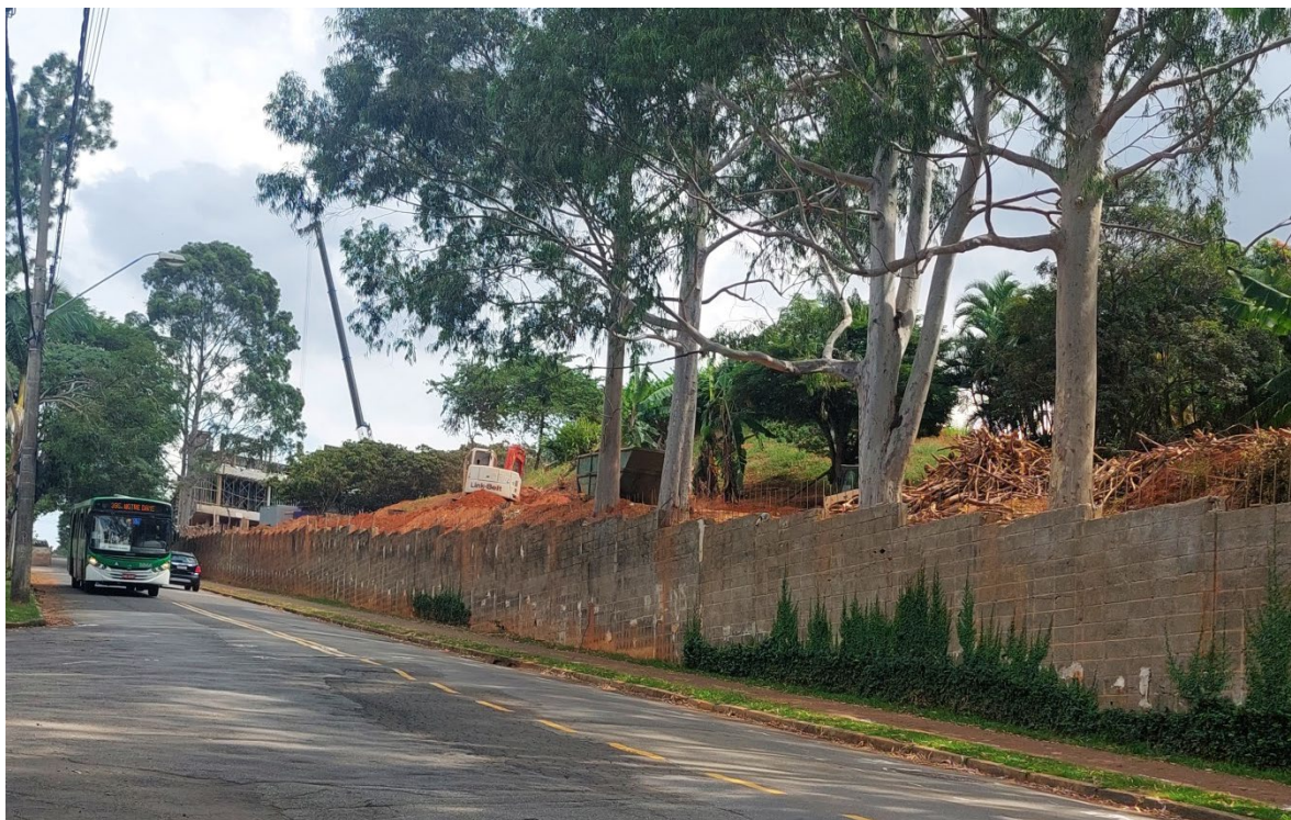
Foto 9. Rua Antônio Marchilli com vista para o muro da Sociedade Hípica de Campinas.
