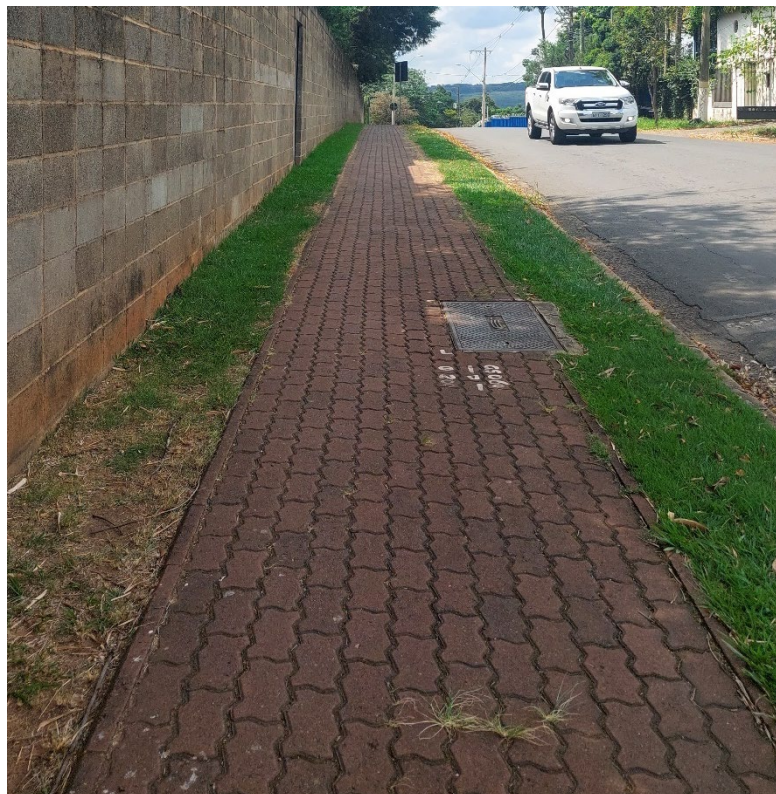
Foto 36. Passeio Público na Rua Antônio Marchilli, em frente a Hípica.
