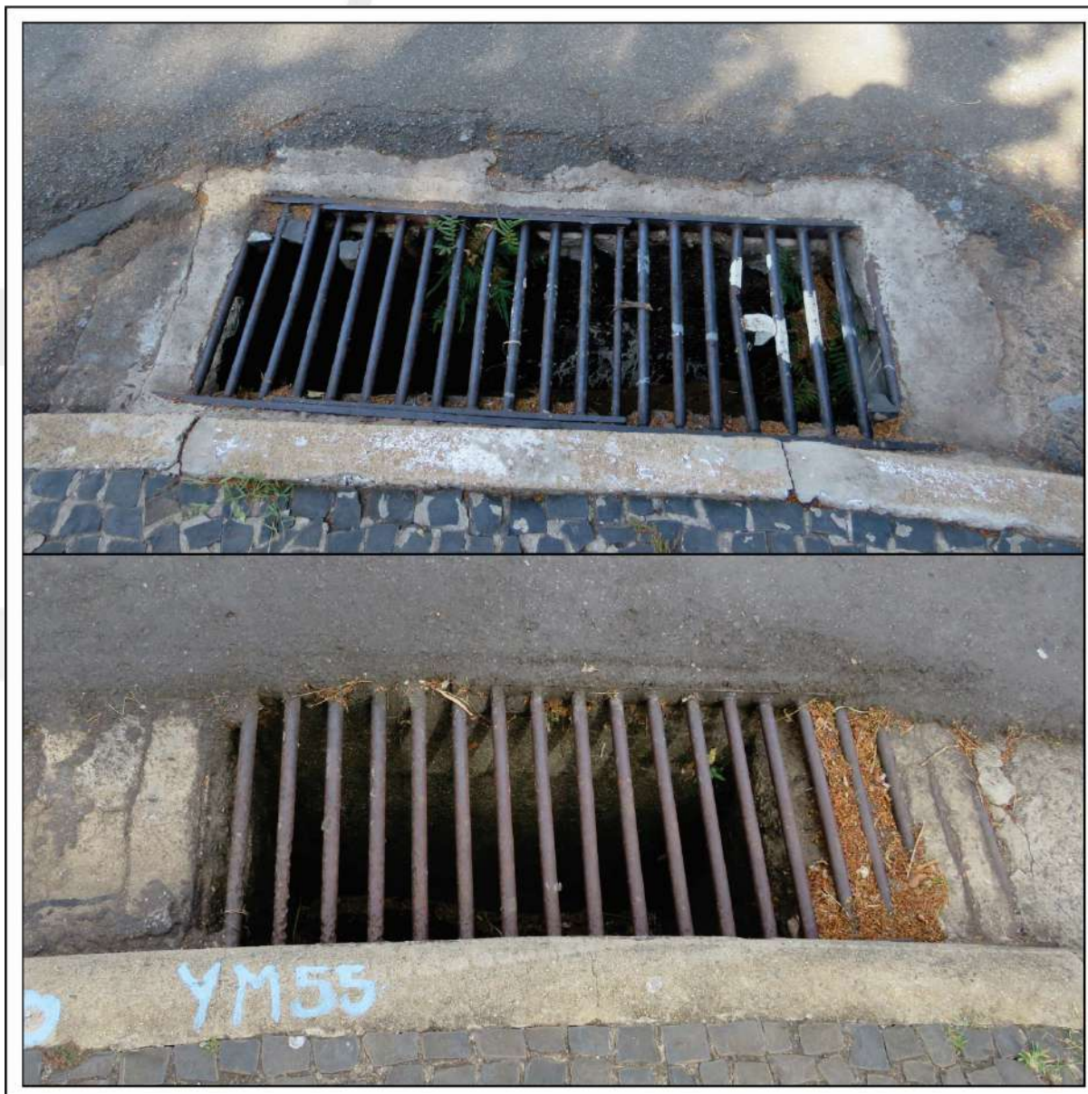
Figura 21. Fotografias - Bocas de lobo. Elaborado por Global Vias.
