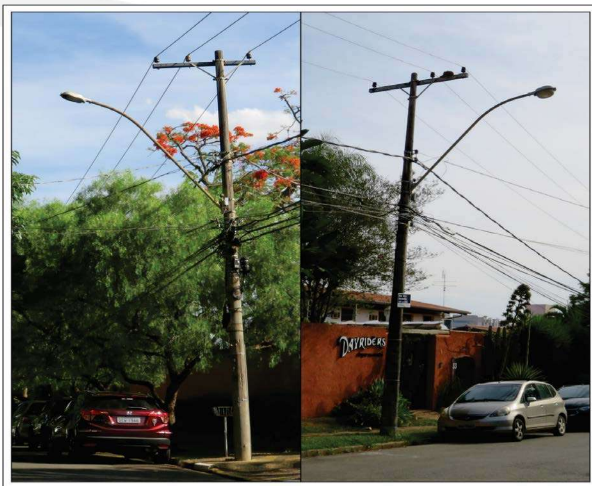
Figura 20. Fotografias – Postes de iluminação pública Fonte: Google Earth – Modificado por Global Vias
