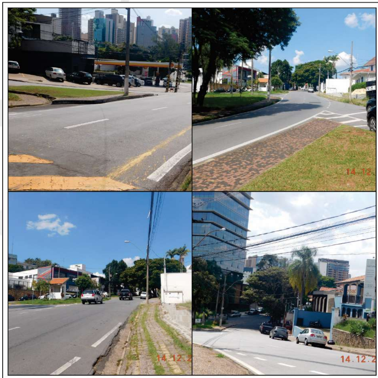
Figura 22. Fotografias - vias no entorno do empreendimento
