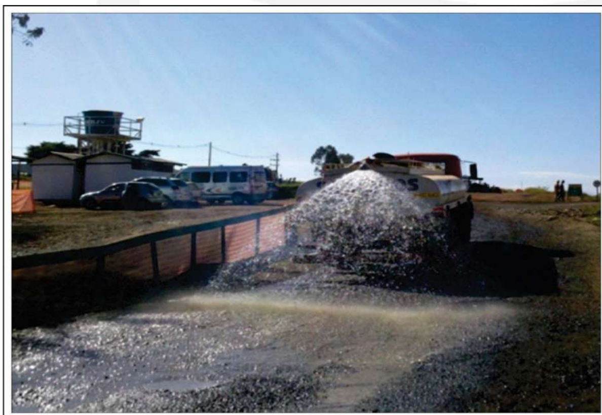
Figura 12. Exemplo de umidificação de solo na obra.
