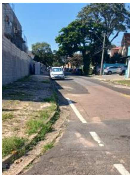
Figura 8 – Rua Augusto César de Andrade. Fonte: Foto Tirada pela Engenheira.
