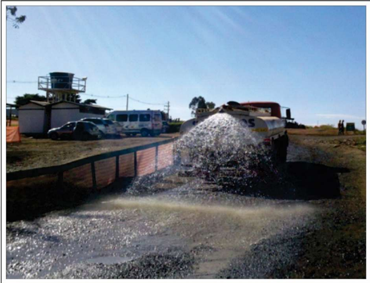
Figura 19. Exemplo de umidificação de solo na obra. Fonte: Global Vias
