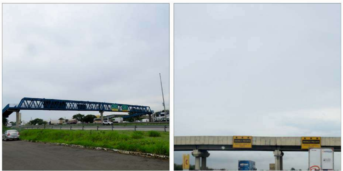
Figura 31. Fotografias – Passarelas para pedestres. Elaborado por Global Vias.
