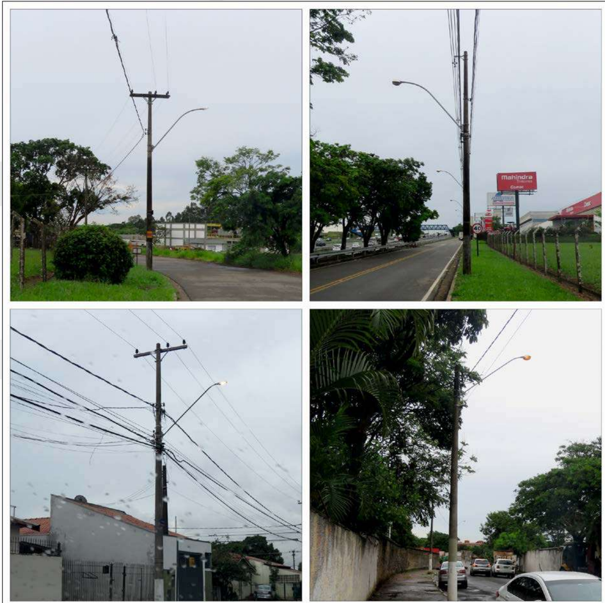
Figura 27. Fotografias – Postes de iluminação pública. Elaborado por Global Vias.
