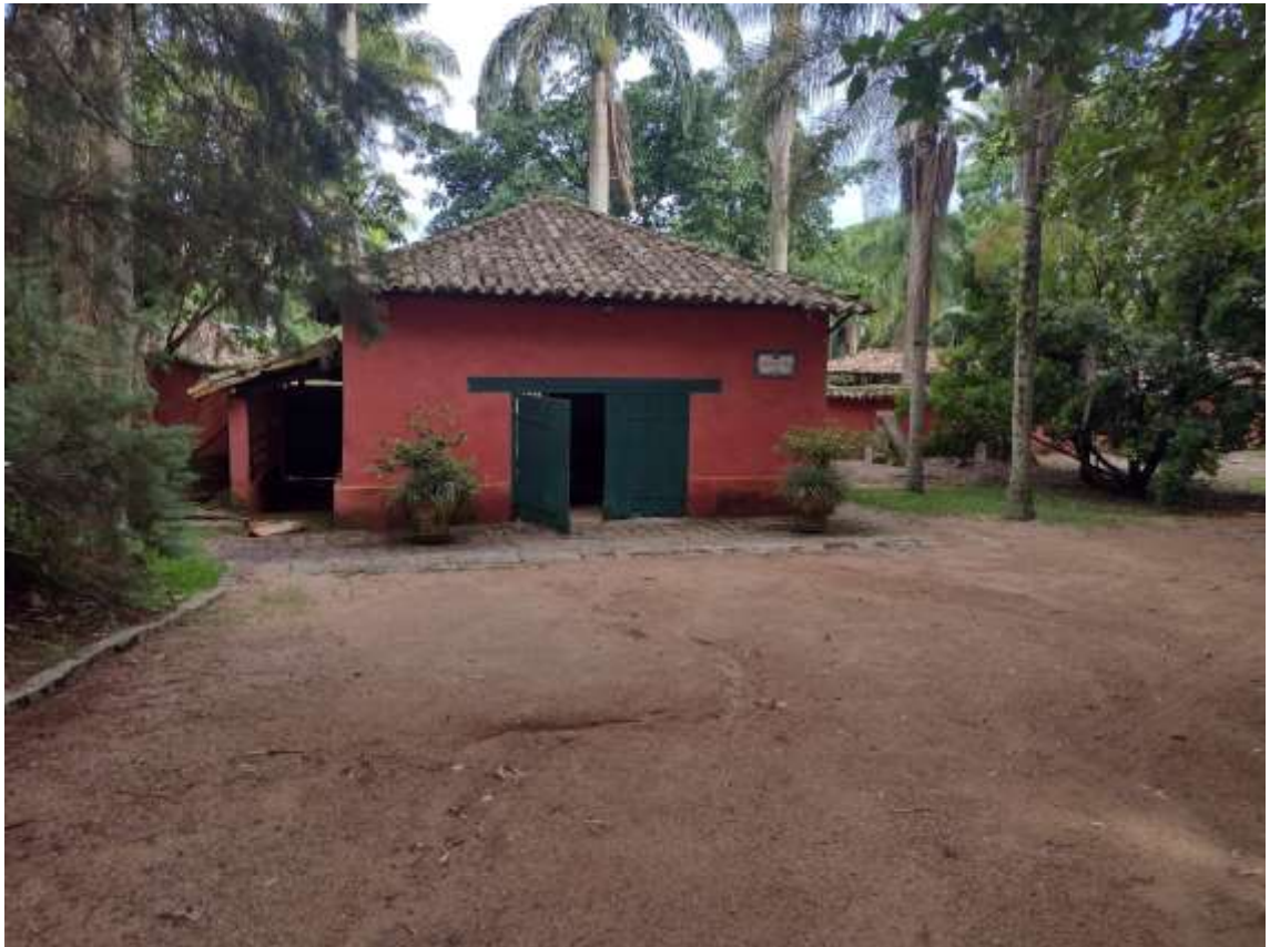
Foto 14: Hall de Entrada – Propriedade - AID.
