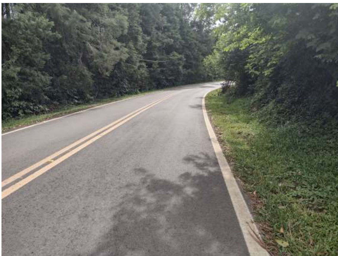
Foto 7: Via de Acesso a Propriedade – Rodovia José Bonifácio Coutinho Nogueira – AID.
