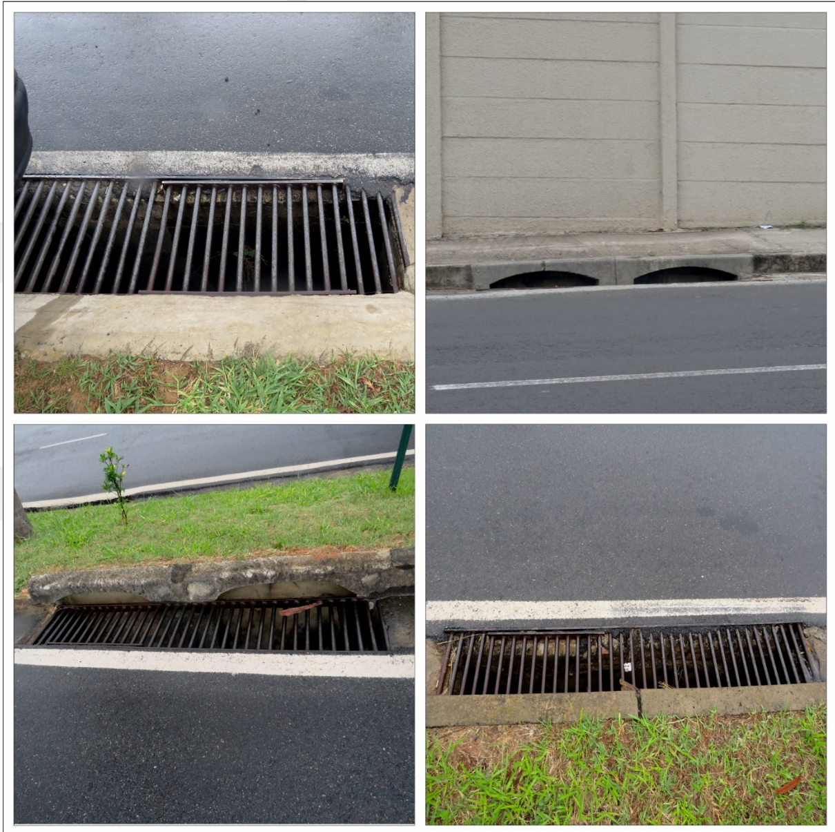
Figura 20. Fotografias - Bocas de lobo. Elaborado por Global Vias.
