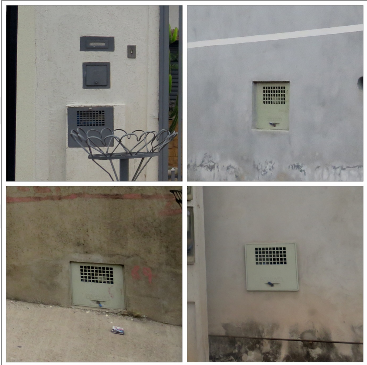
Figura 17. Fotografias – Equipamentos medidores das redes de água e esgoto. Elaborado por Global Vias.
