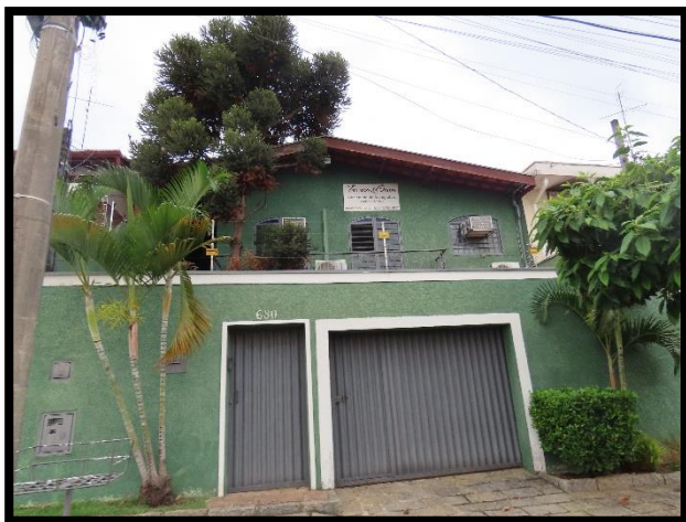
Foto 29: Uso misto verificado no CIS.
