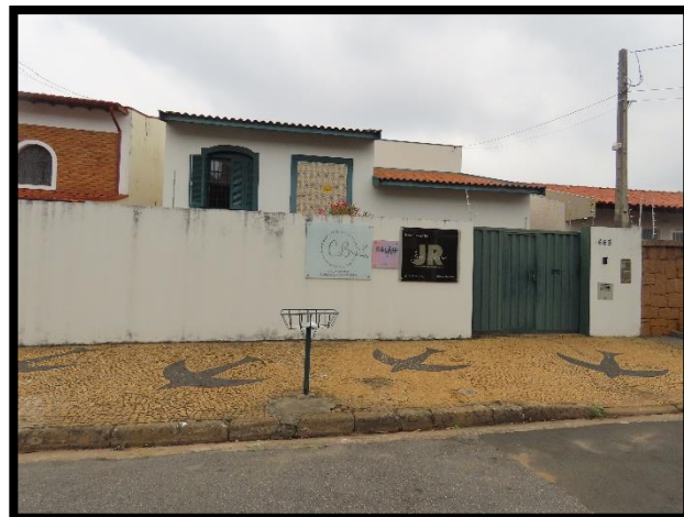
Foto 28: Uso misto verificado no CIS.
