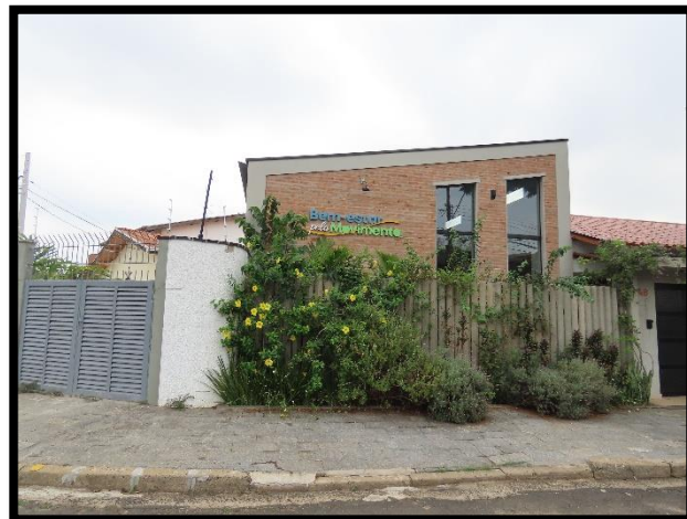
Foto 32: Uso misto verificado no CIS.
