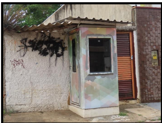
Foto 17: Guarita instalada de forma particular por morador do CIS.
