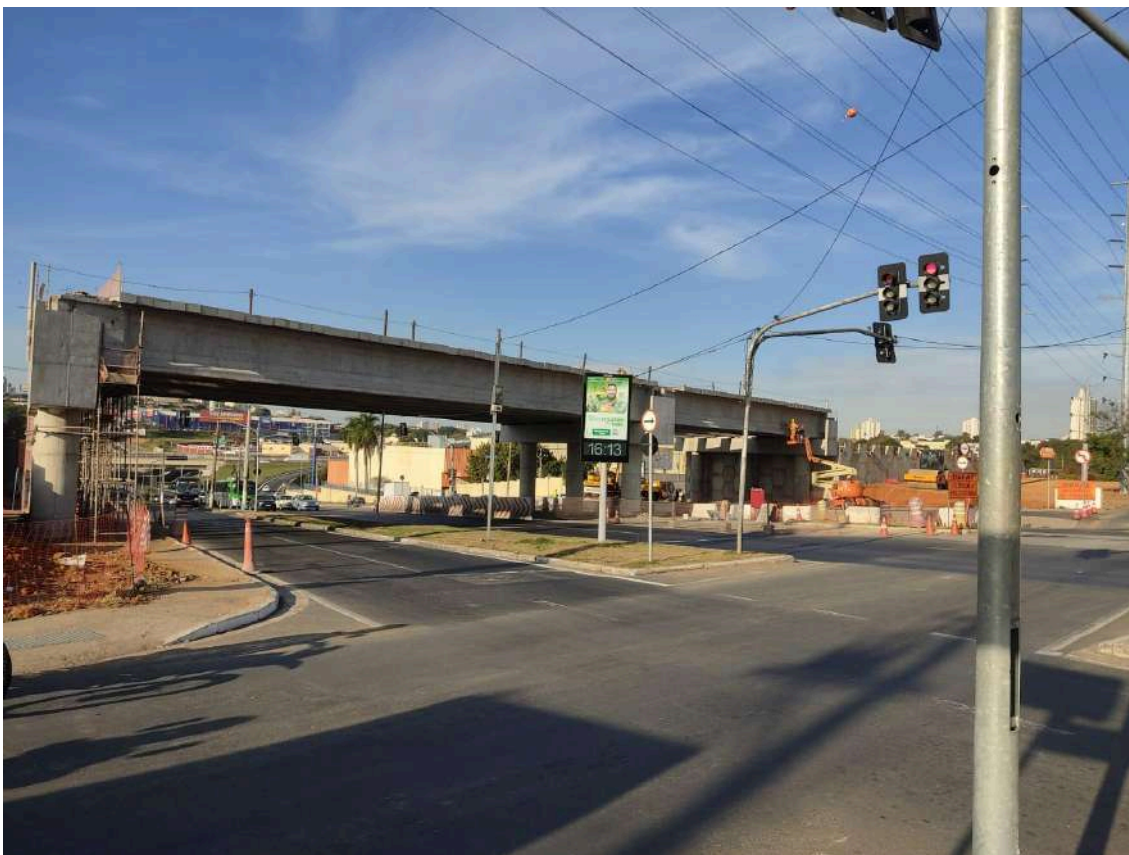
Figura 33 – Construção do viaduto interligando as Ruas Alfredo Batibugli (Jardim Garcia) e Padre João Batista Carvalho (Jardim Paulicéia).
