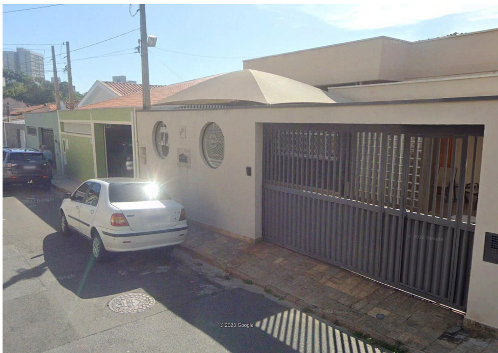
Figura 9. Área residencial unifamiliar localizada na Rua Saint Hilaire.
