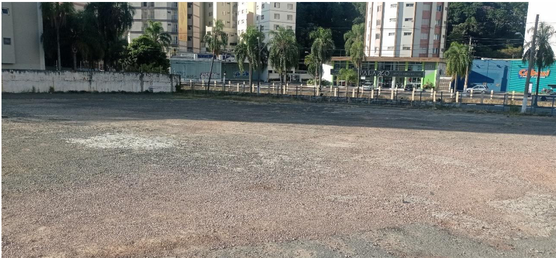
Figura 06. Vista geral do lote.
