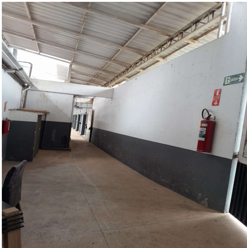
foto 39 - vista interna do imóvel
