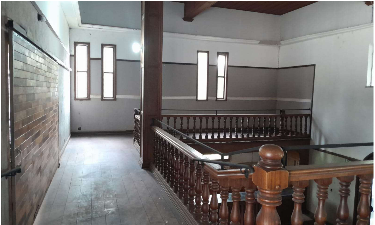
foto 49.B - vista interna do salão A
