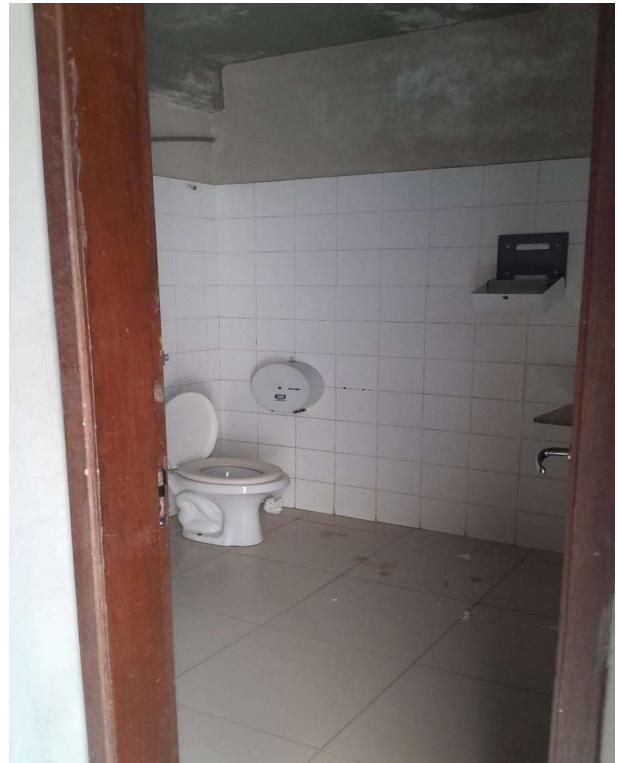
foto 16 - vista banheiro escritório
