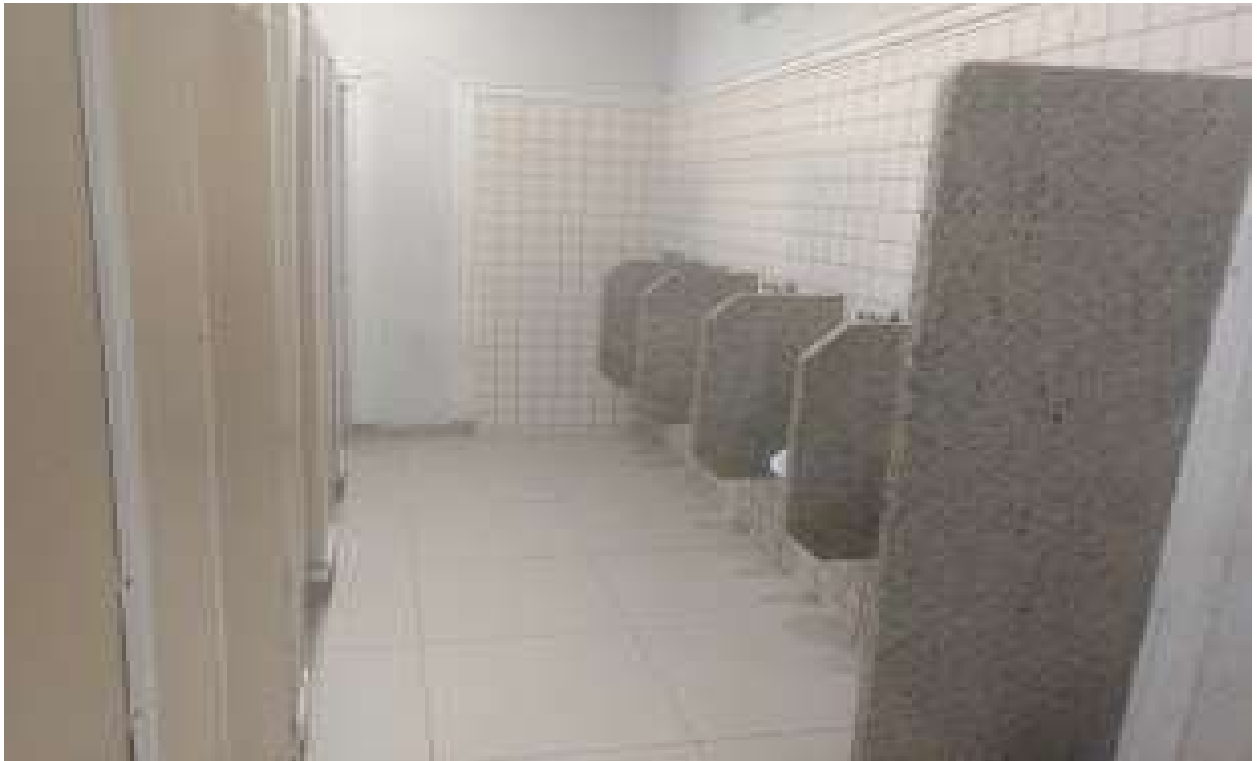
foto 33.A - vista interna banheiro masculino
