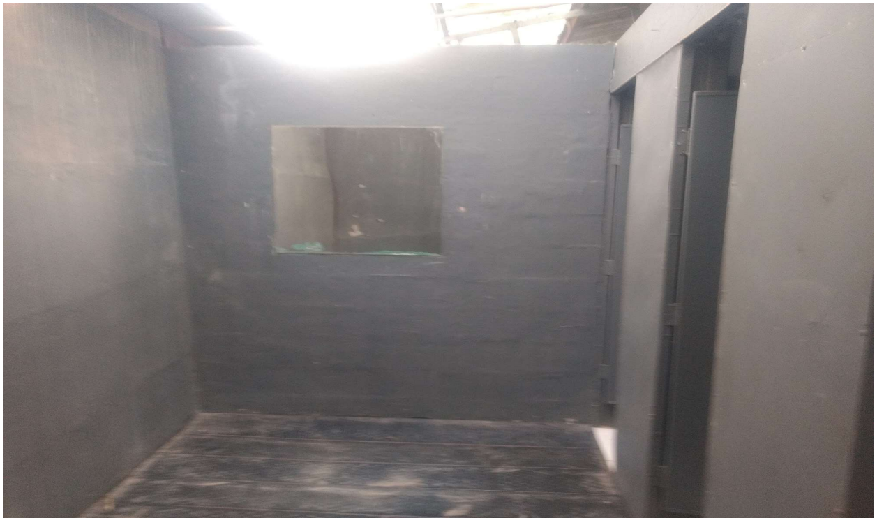
foto 45 - vista do banheiro feminino
