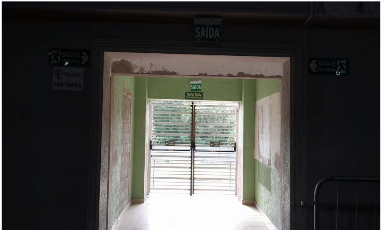
foto 09 - vista porta de saída ( emergência), entrada banheiros
