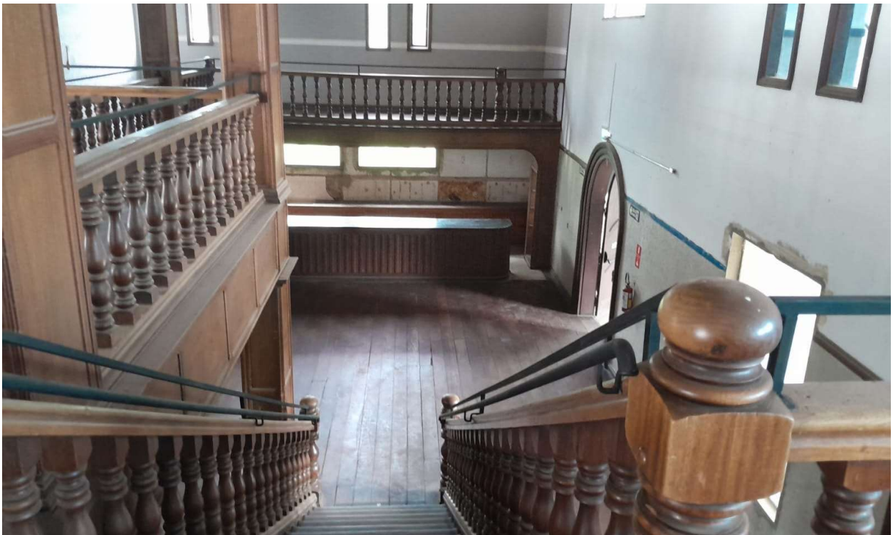
foto 07 - vista do mezanino olhando para bar e porta entrada/saída opção 02
