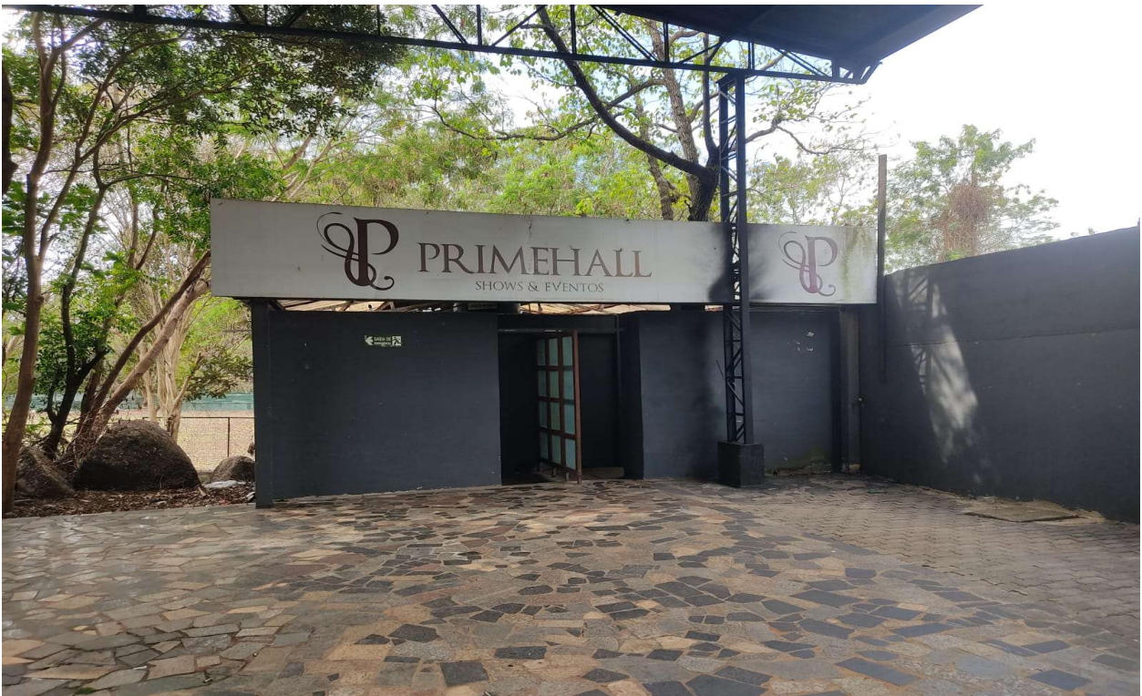
foto 43/44 - vista das entrada dos banheiro inferiores
