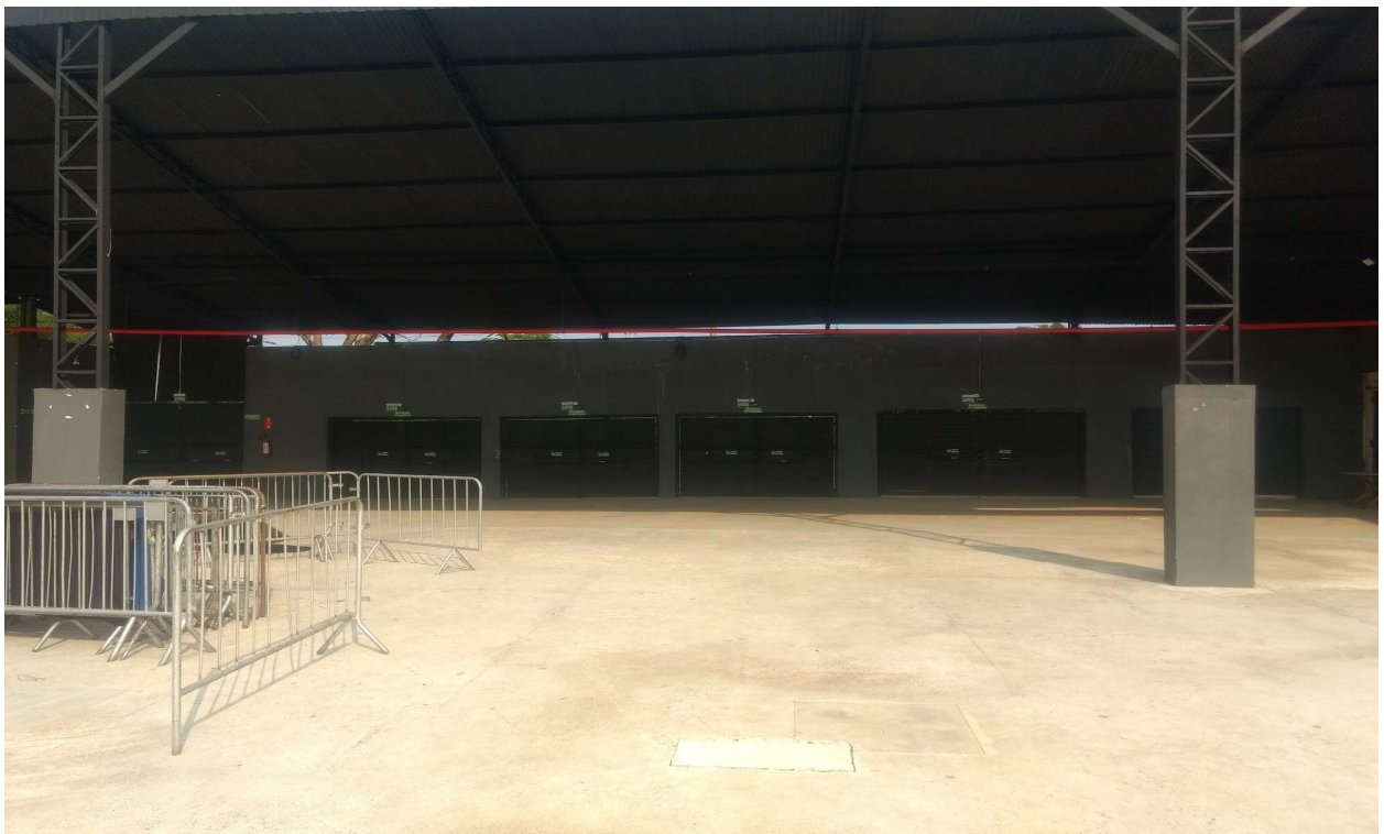
foto 25.A - vista interna do salão descoberto/saídas de emergência
