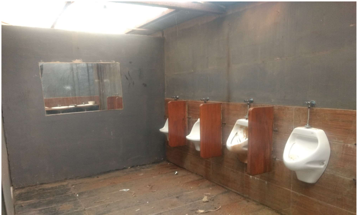
foto 43.A - vista do banheiro masculino
