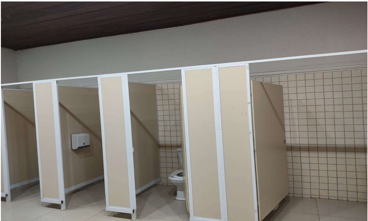
foto 33.B - vista interna banheiro feminino
