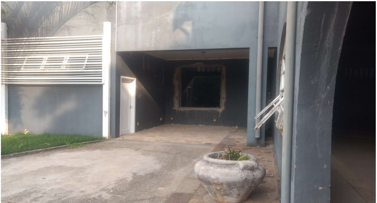
foto 17.A - vista área externa ao lado da porta de entrada/saída opção 02
