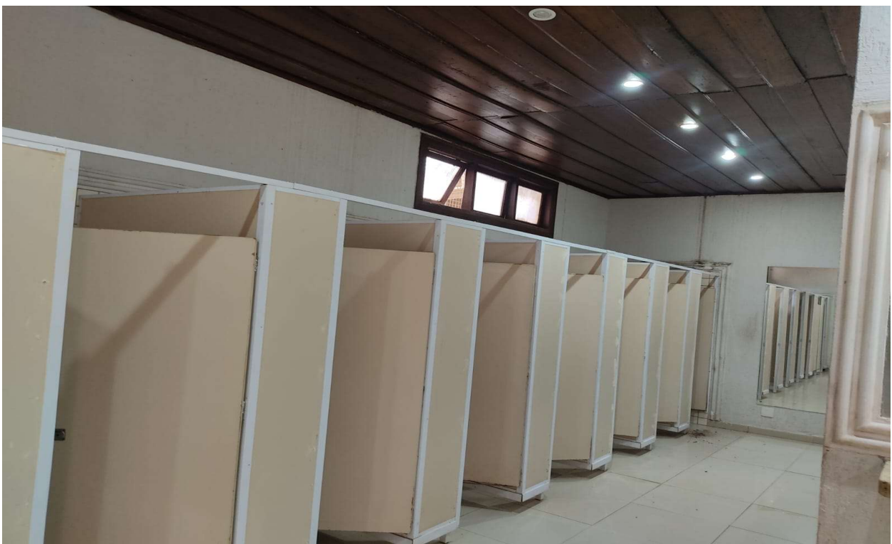
foto 32 - vista interna banheiro feminino localizado no salão descoberto ( vide posição foto 23)
