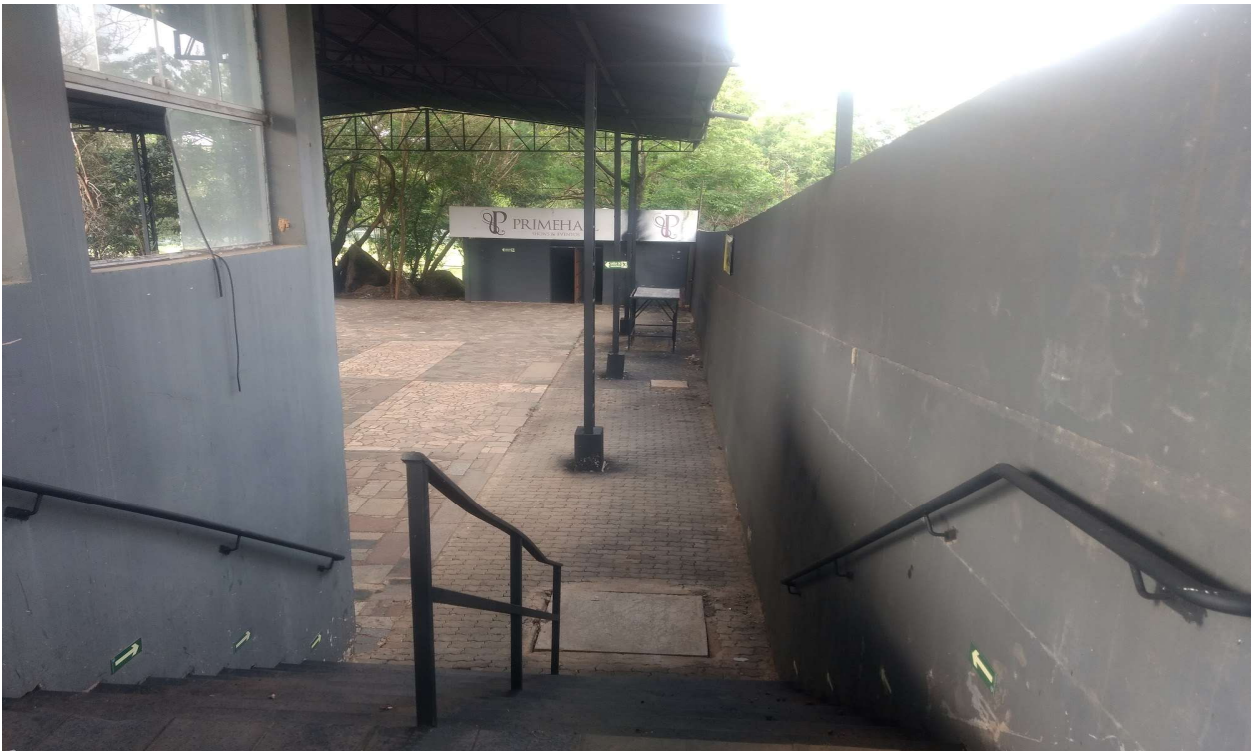
foto 41 - vista interna do imóvel para o acesso jardim inferior
