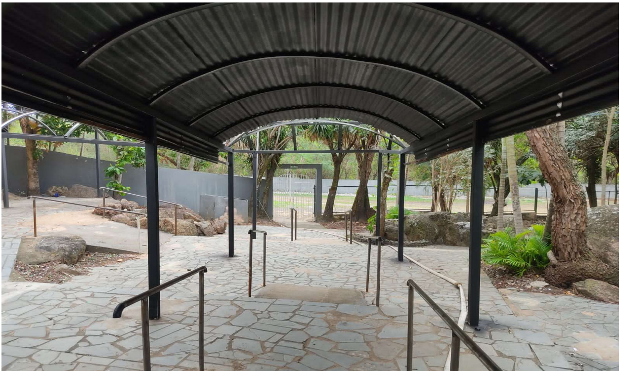
foto 47.C - vista do espaço jardim inferior/ passarela acesso ao estacionamento
