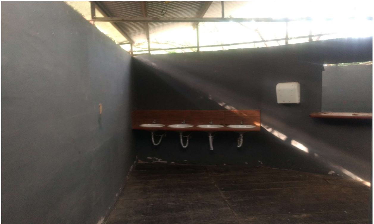
foto 44.B - vista do banheiro feminino
