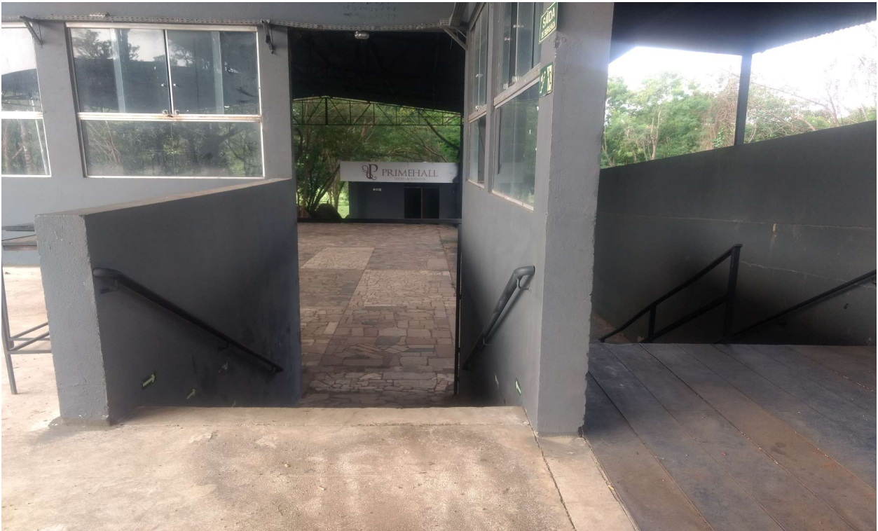
foto 40 - vista interna do imóvel da escada de acesso ao jardim inferior
