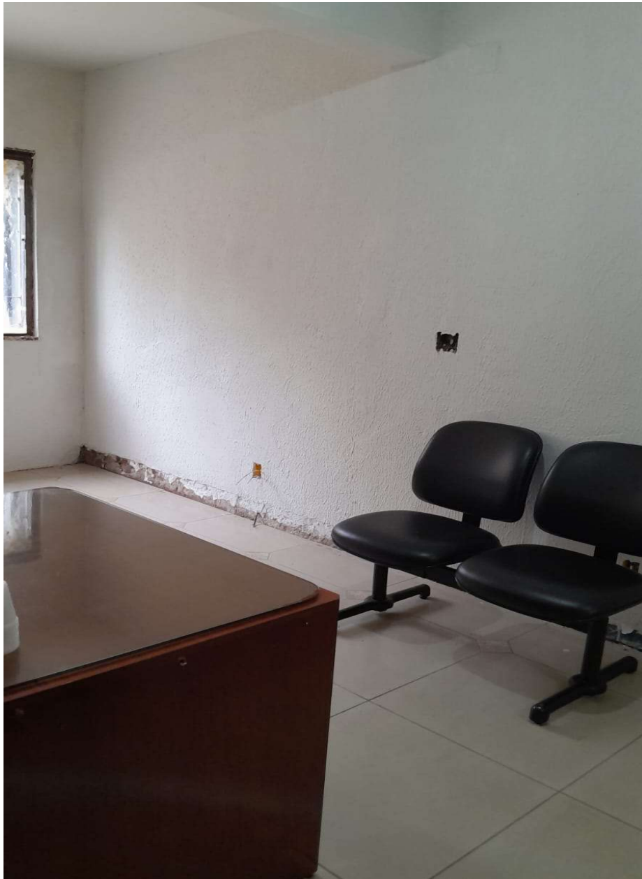
foto 14.B - vista interna do escritório (foto 14.A)
