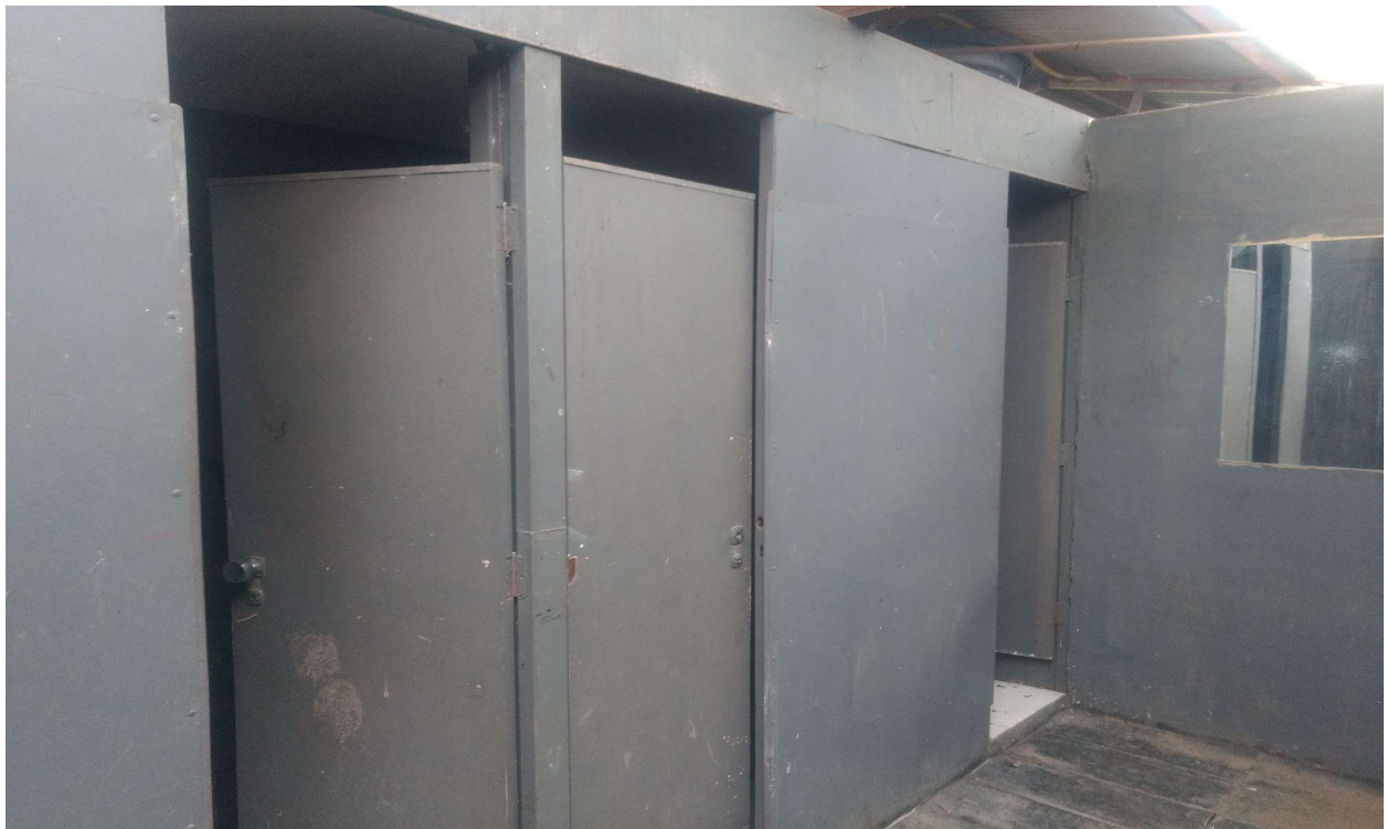
foto 43.B - vista do banheiro masculino
