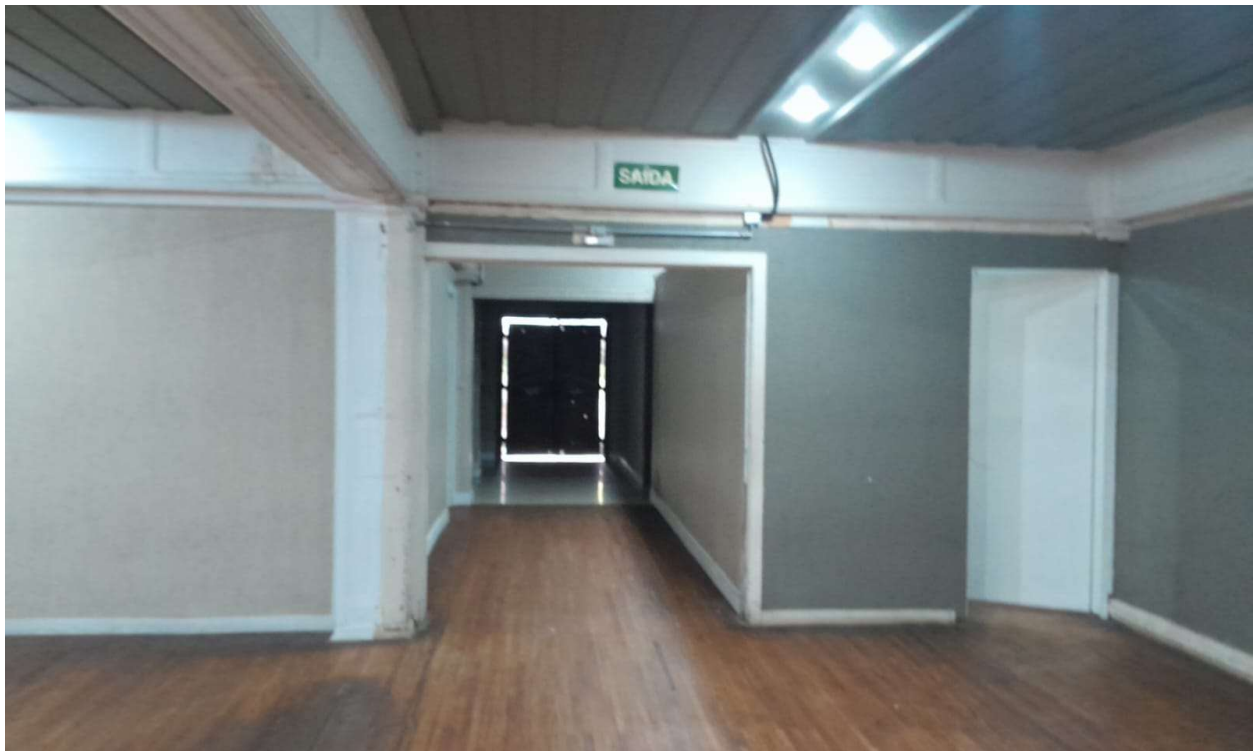
foto 12 - vista saída para jardim/escritório/banheiros/sala qualquer
