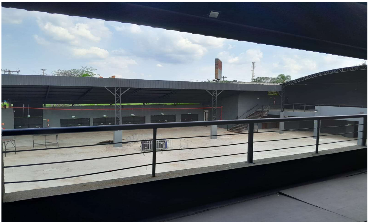
foto 30 - vista interna piso superior olhando para o piso superior e saídas de emergência
