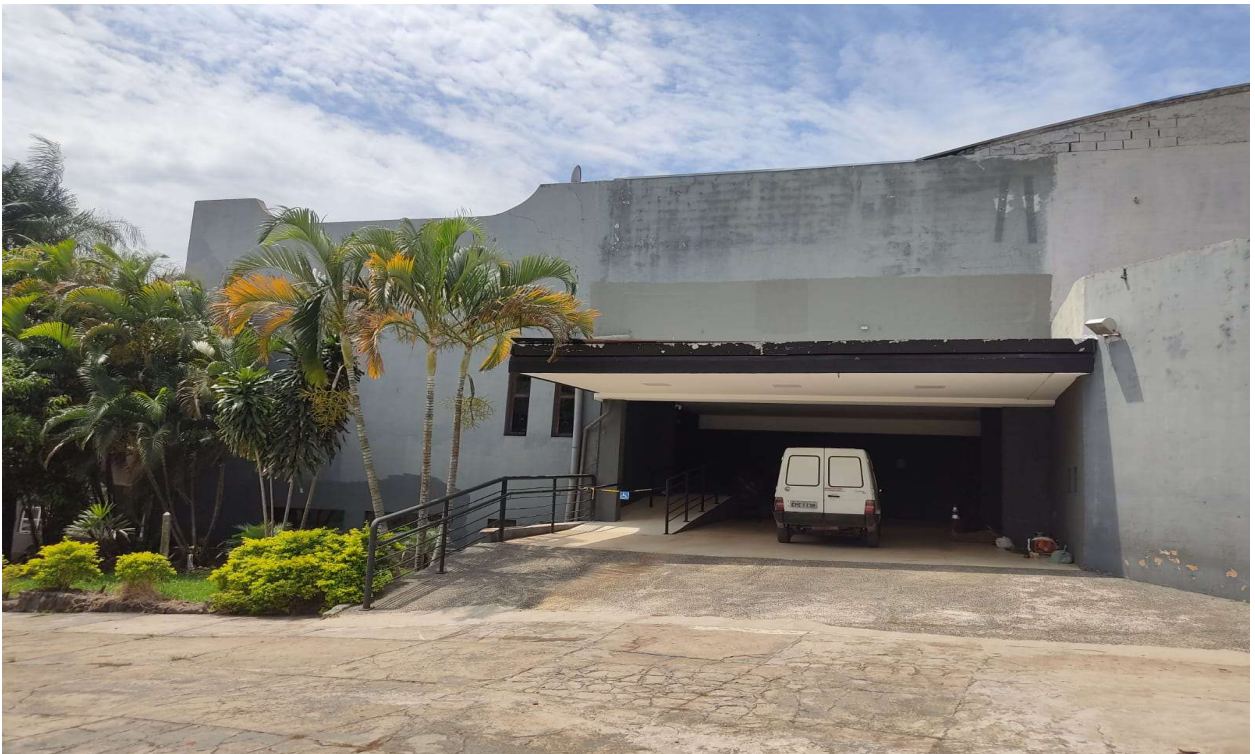
foto 19 - vista área externa entrada principal
