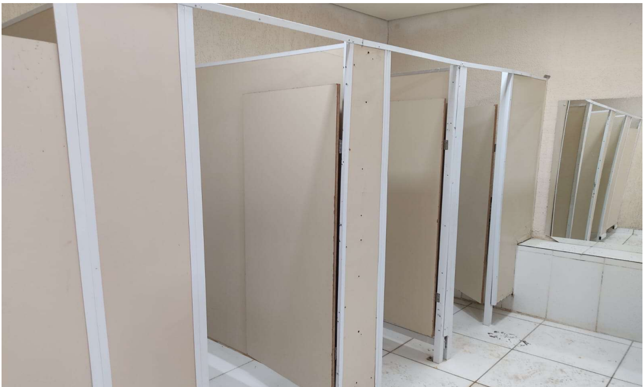
foto 55 - vista banheiro feminino do salão C
