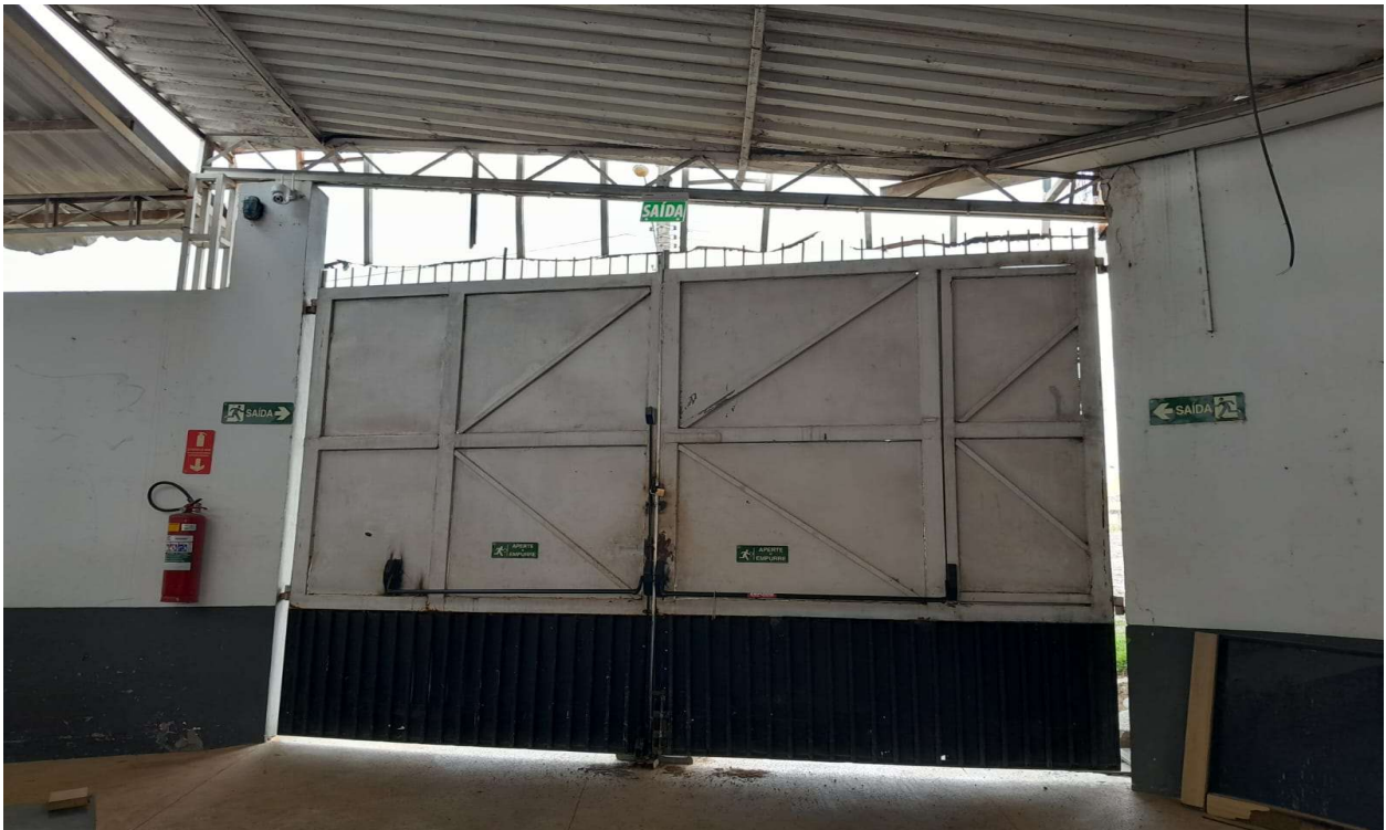
foto 35.A - espaço cozinha/ portão saída e entrada de serviços
