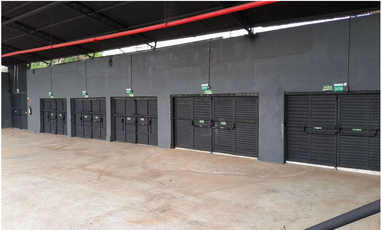
foto 25.B - vista interna do salão descoberto/saídas de emergência
