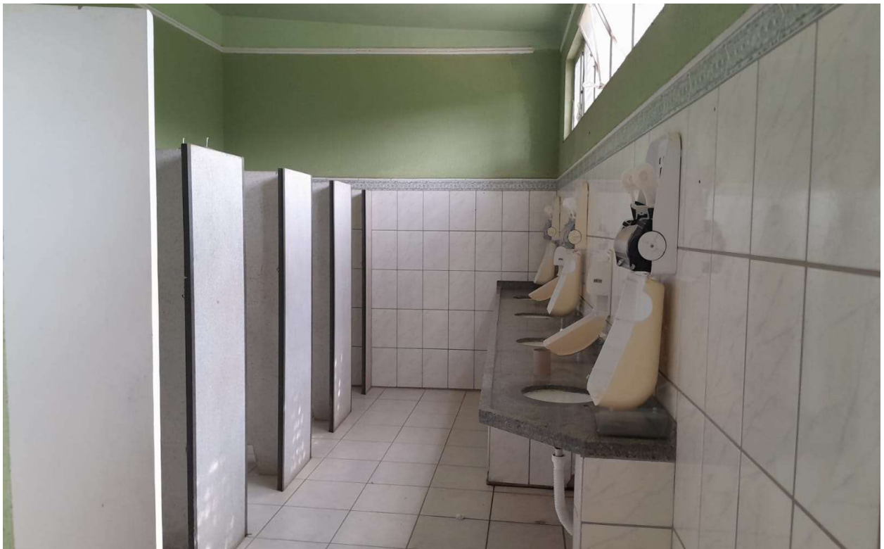
foto 10 - vista banheiro feminino
