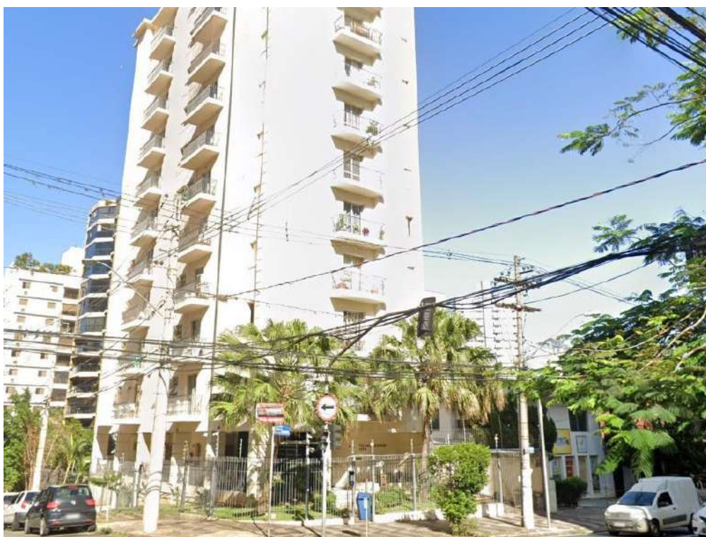
Figura 21. Área residencial multifamiliar localizada na Av. Júlio de Mesquita.
