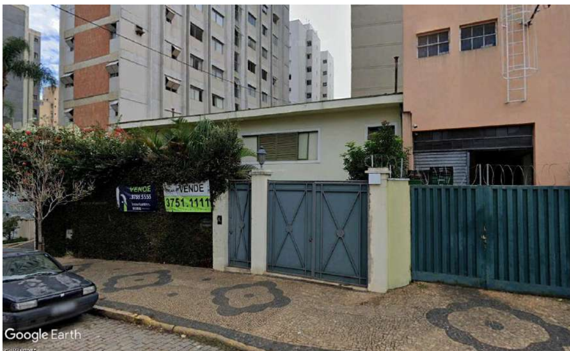
Figura 06. Vista do lote 017.
