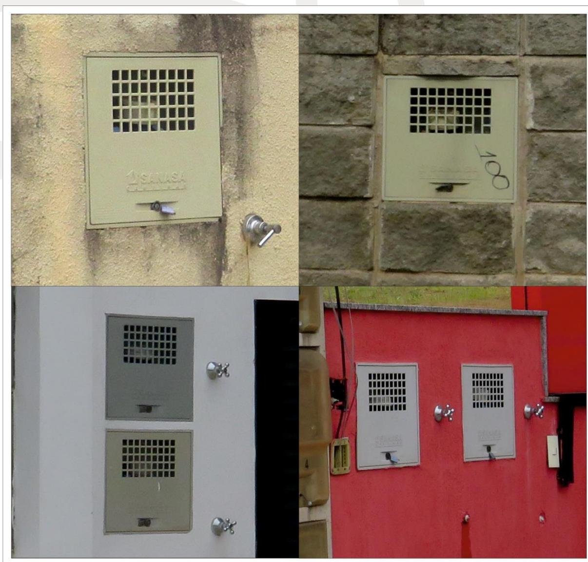
Figura 17. Fotografias – Equipamentos medidores das redes de água e esgoto.
