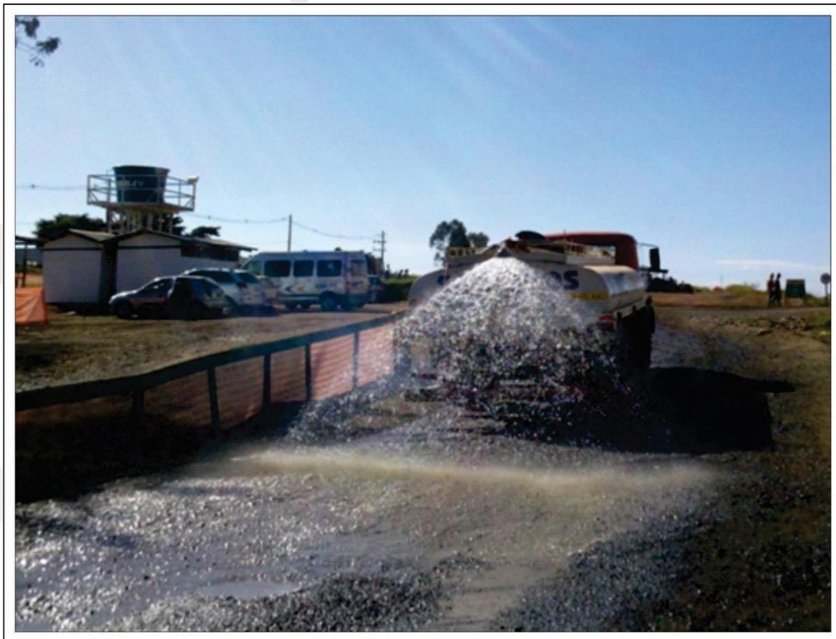
**Figura 11. Exemplo de umidificação de solo na obra.**
