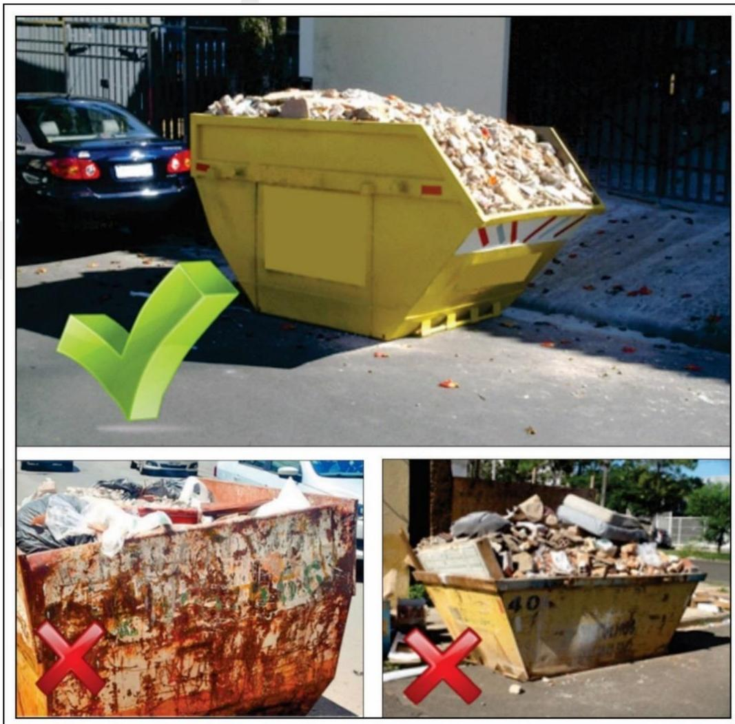
Figura 15. Modelo de acondicionamento de resíduos em caçambas.
