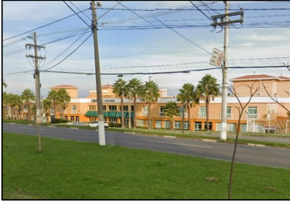
Foto 13. Condomínio de escritórios (Leste da AID).
