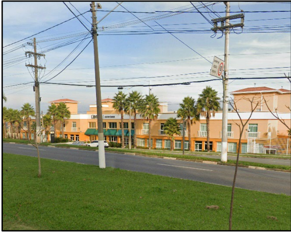
Foto 13. Condomínio de escritórios (Leste da AID).
