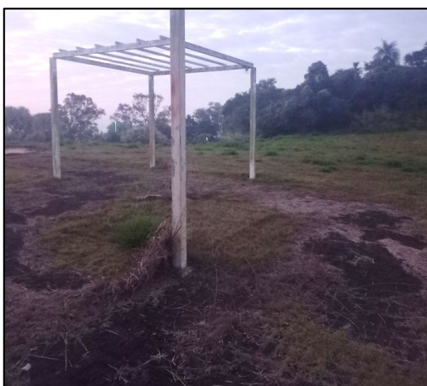
Foto 4. Solo impermeabilizado e estrutura metálica – ADA.
