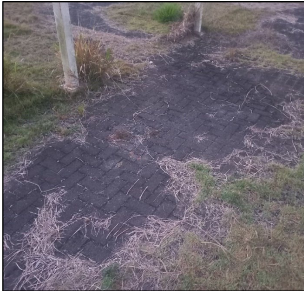
Foto 7. Solo impermeabilizado – ADA.
