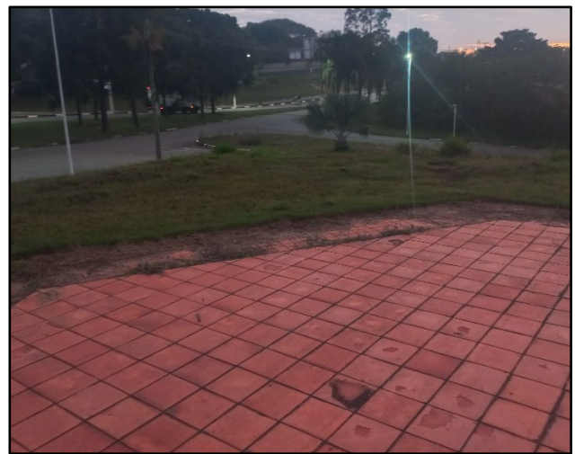
Foto 12. Trecho de solo impermeabilizado – ADA.
