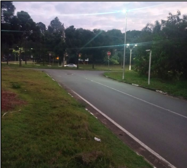
Foto 19. Avenida Recanto das Araucárias sentido saída do loteamento – P2.
