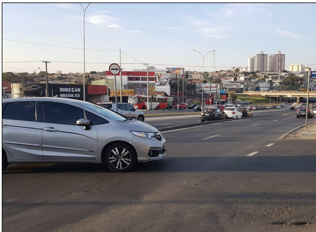
Figura 16. Vista geral de outro ponto da Avenida John Boyd Dunlop, onde é possível observar boa sinalização vertical e horizontal.
