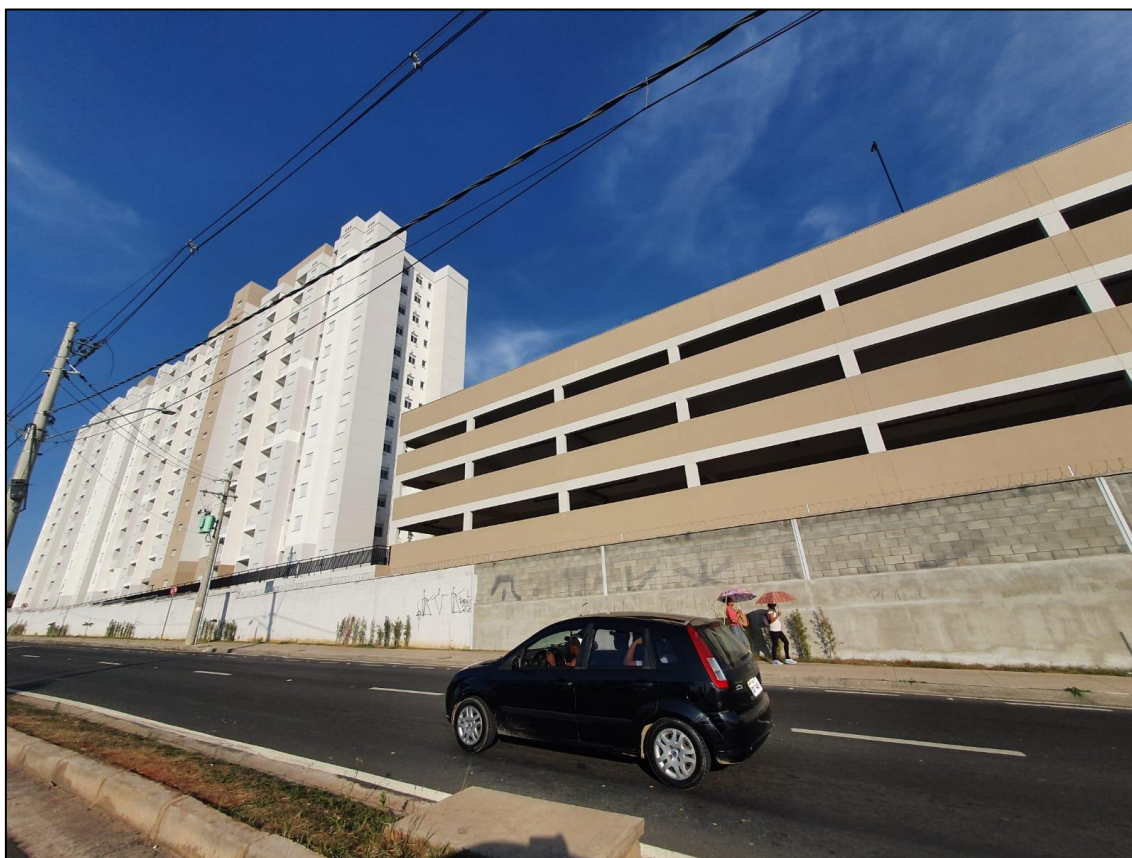
Figura 14. Uso residencial multifamiliar em frente ao empreendimento na Avenida John Boyd Dunlop.
