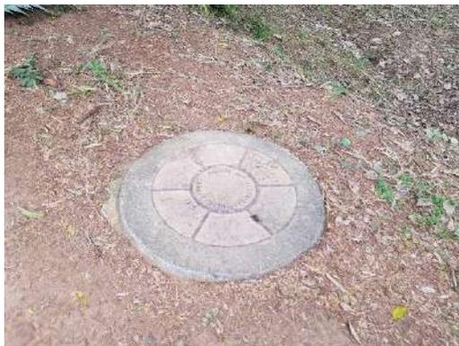
**Imagem 32.** Ponto de inspeção de águas pluviais dentro do Campus II, em área verde.
