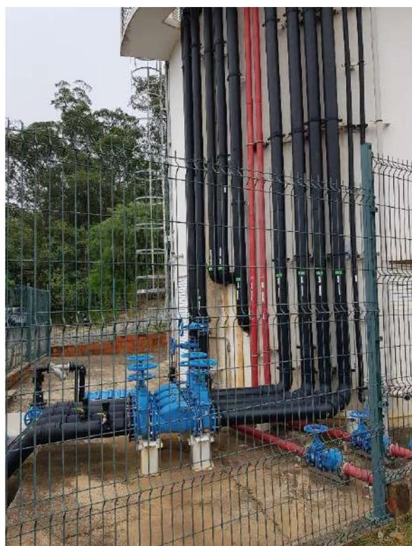
Imagem 26. Detalhe da tubulação da torre de água potável para a Universidade.
