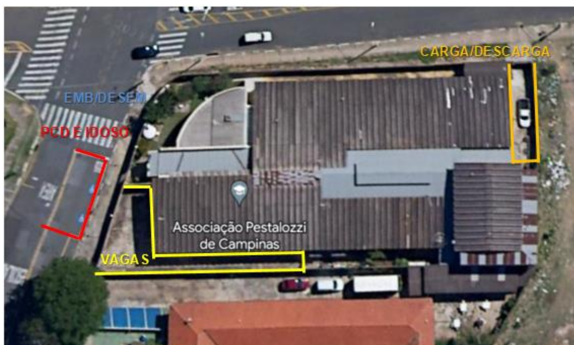
Figura 4 – Áreas de estacionamento do empreendimento.
