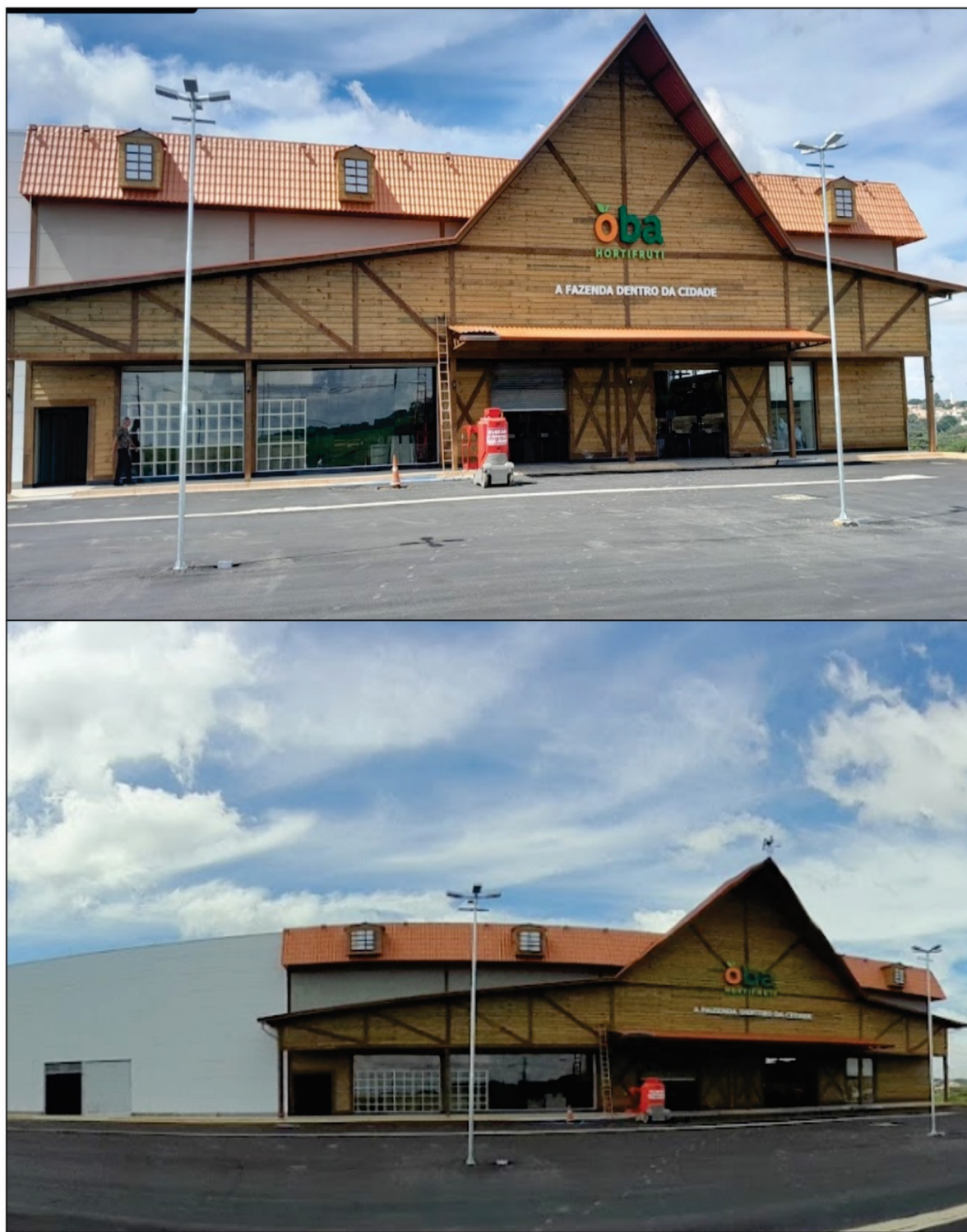
Figura 5. Fachada atual do empreendimento.
