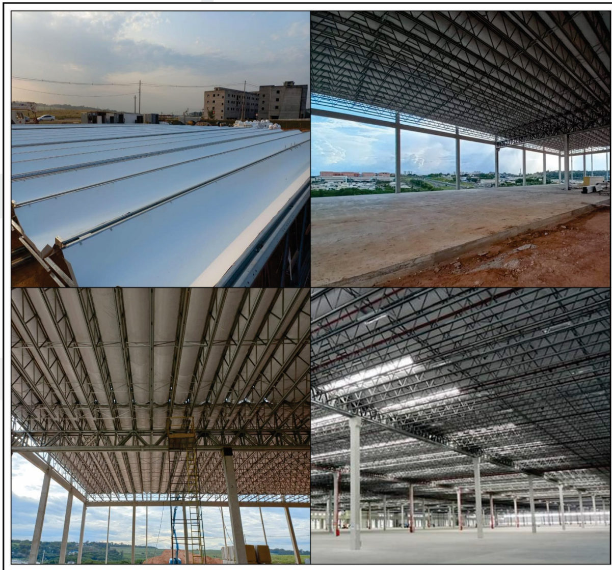
Figura 18. Fotografias da cobertura do empreendimento
