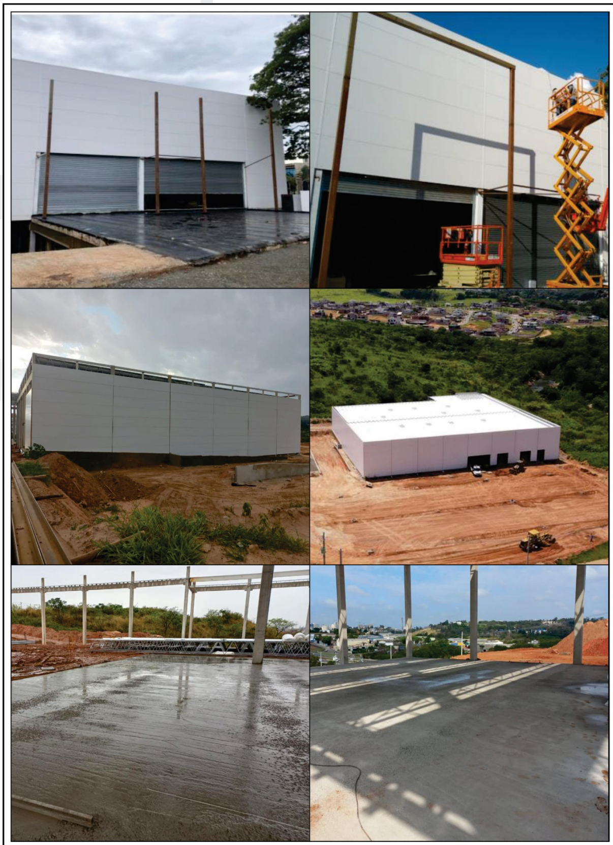
Figura 20. Fotografias dos acabamentos e pisos
