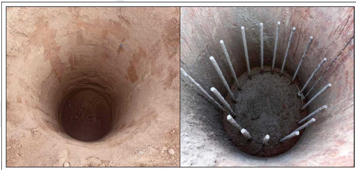
Figura 15. Fotografias da fundação profunda
