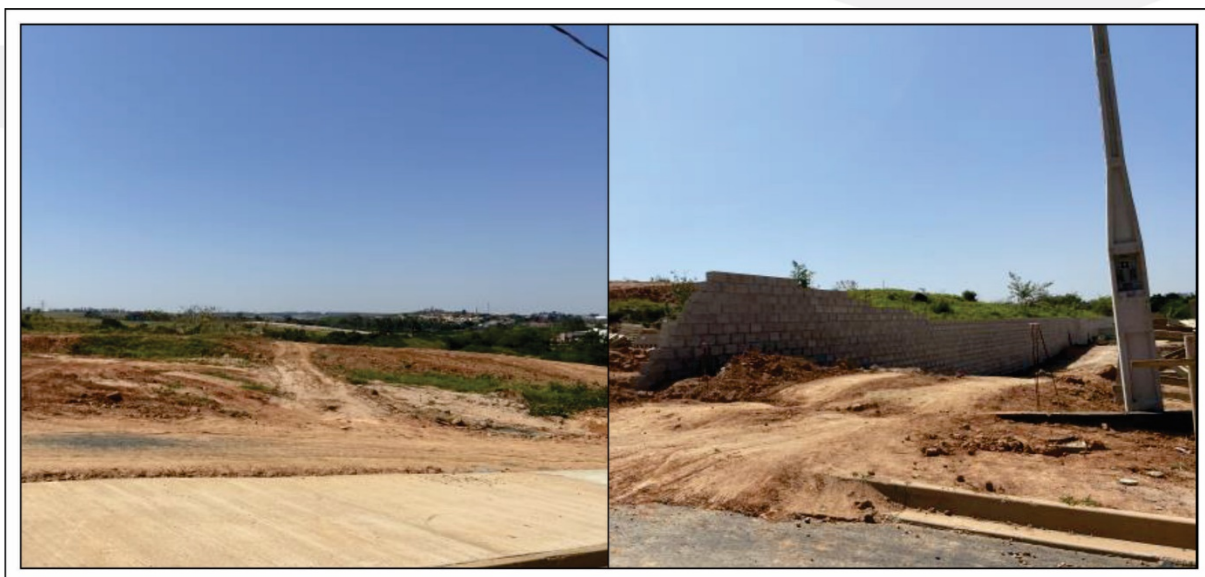
Figura 14. Fotografias da escavação
