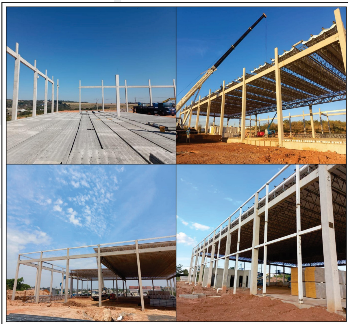
Figura 17. Fotografias da superestrutura
