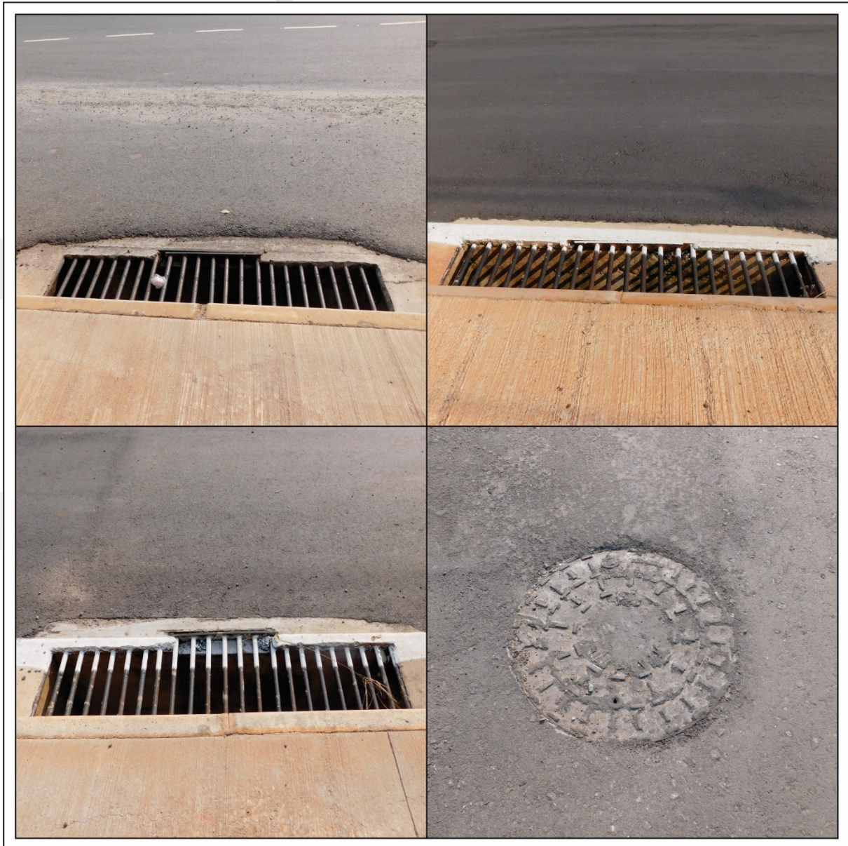
Figura 22. Fotografias - Bocas de lobo. Elaborado por Global Vias.
