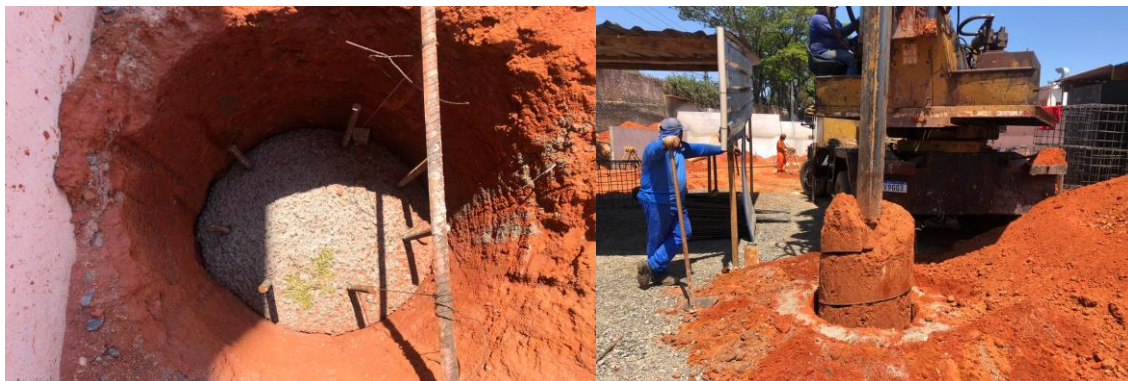
Figura 2: Fundação profunda
