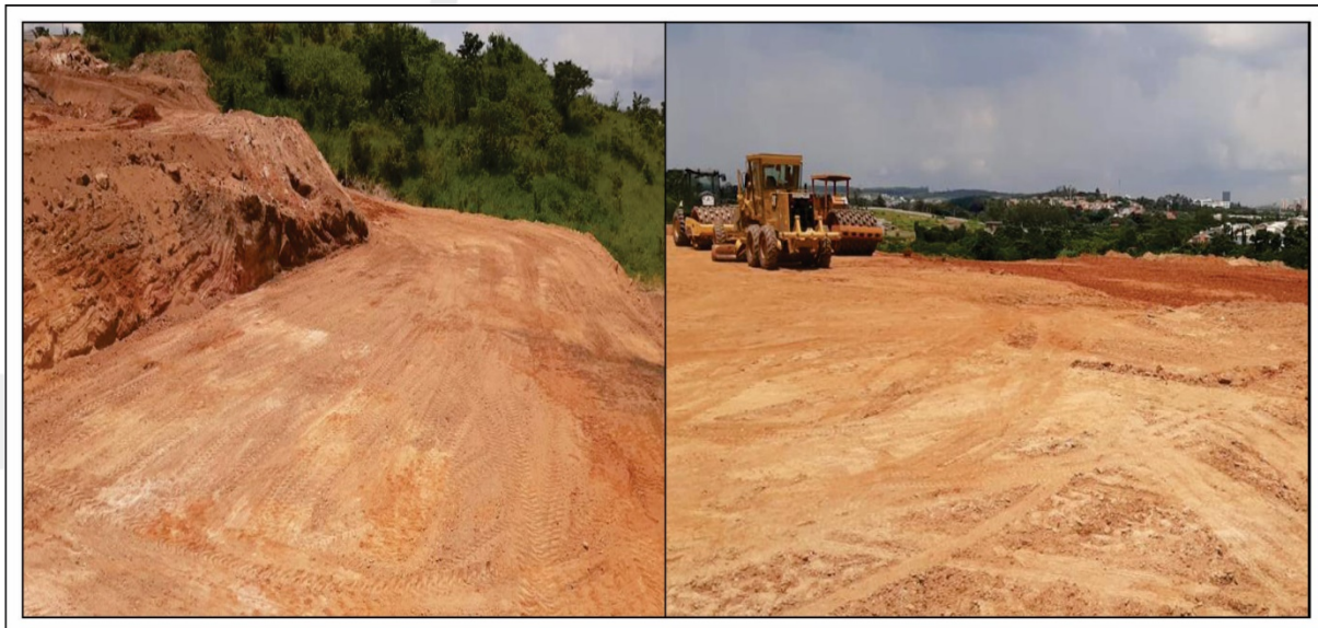
Figura 13. Fotografias da terraplanagem
