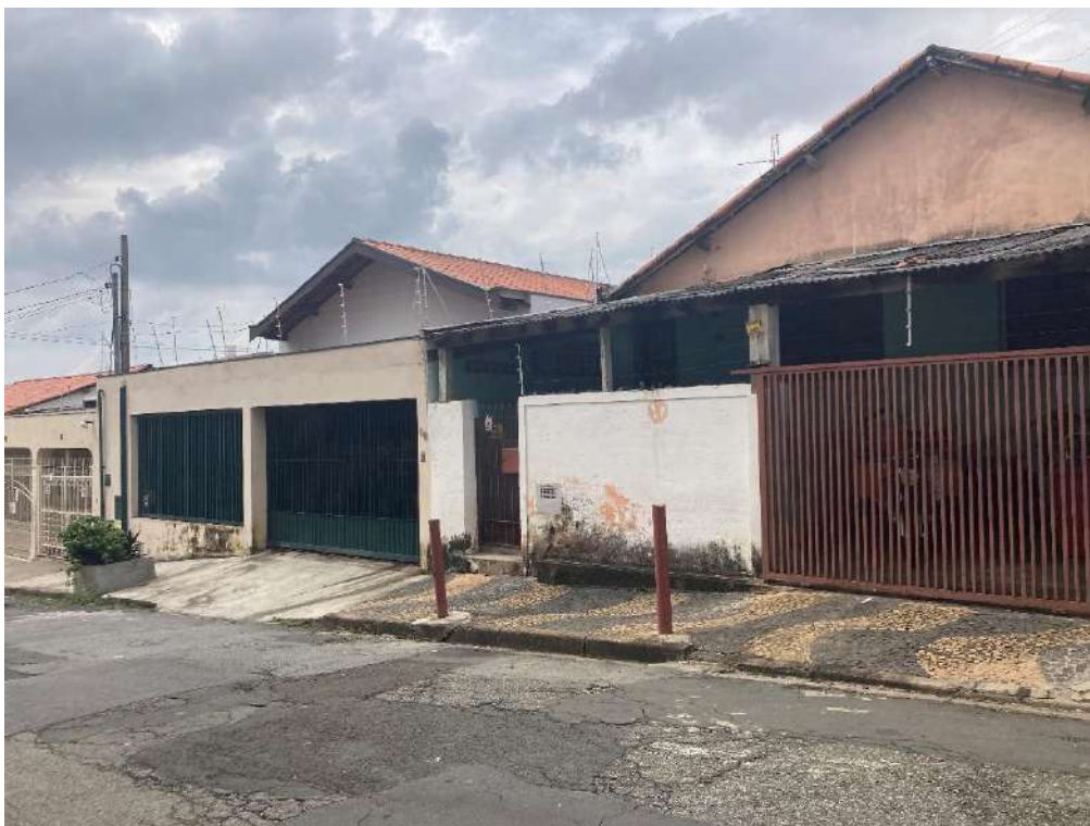
Figura 34. Residências unifamíliares localizadas na All.
