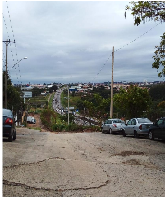
Via Local com pavimentação em concreto, sem guia, sarjeta.
