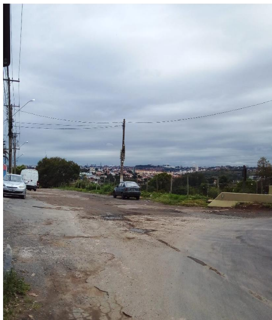
Parte da Rua Eldorado com pavimentação em concreto sem conter guias, passeio, sistema de drenagem e sarjeta, e a direita viaduto com passeio para pedestre.
