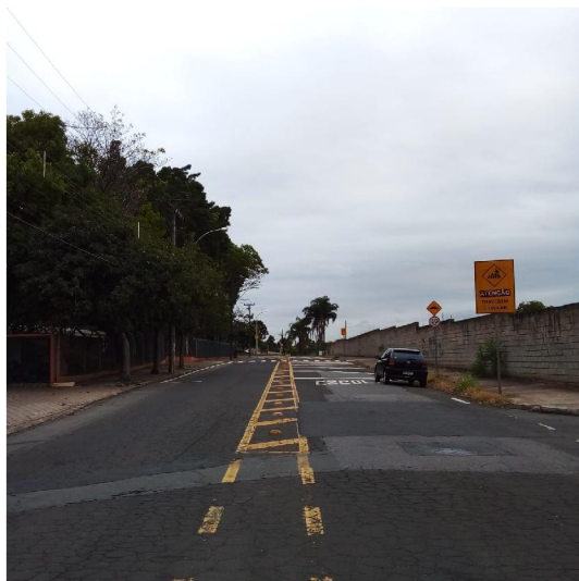
Ponto mais baixo da via Local composto por sarjetas para drenagem pluvial e boca de lobo.
