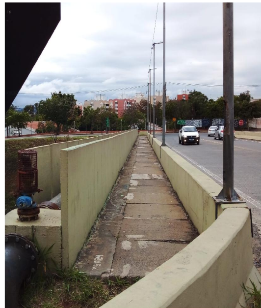
Parte da Rua Eldorado com pavimentação em concreto sem conter guias, passeio, sistema de drenagem e sarjeta, e a direita viaduto com passeio para pedestre.
