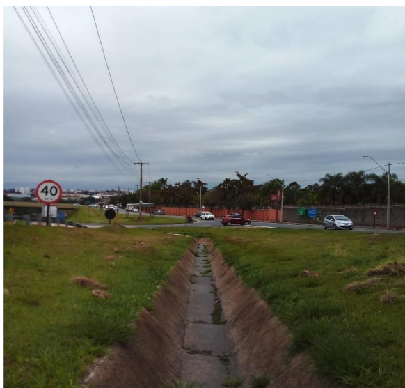
Canaleta no canteiro central da Rua Dr. Gustavo Orsolini.
