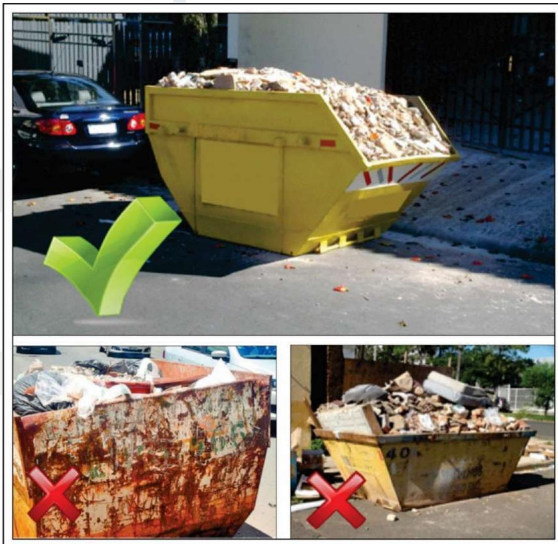
Figura 18. Modelo de acondicionamento de resíduos em caçambas
