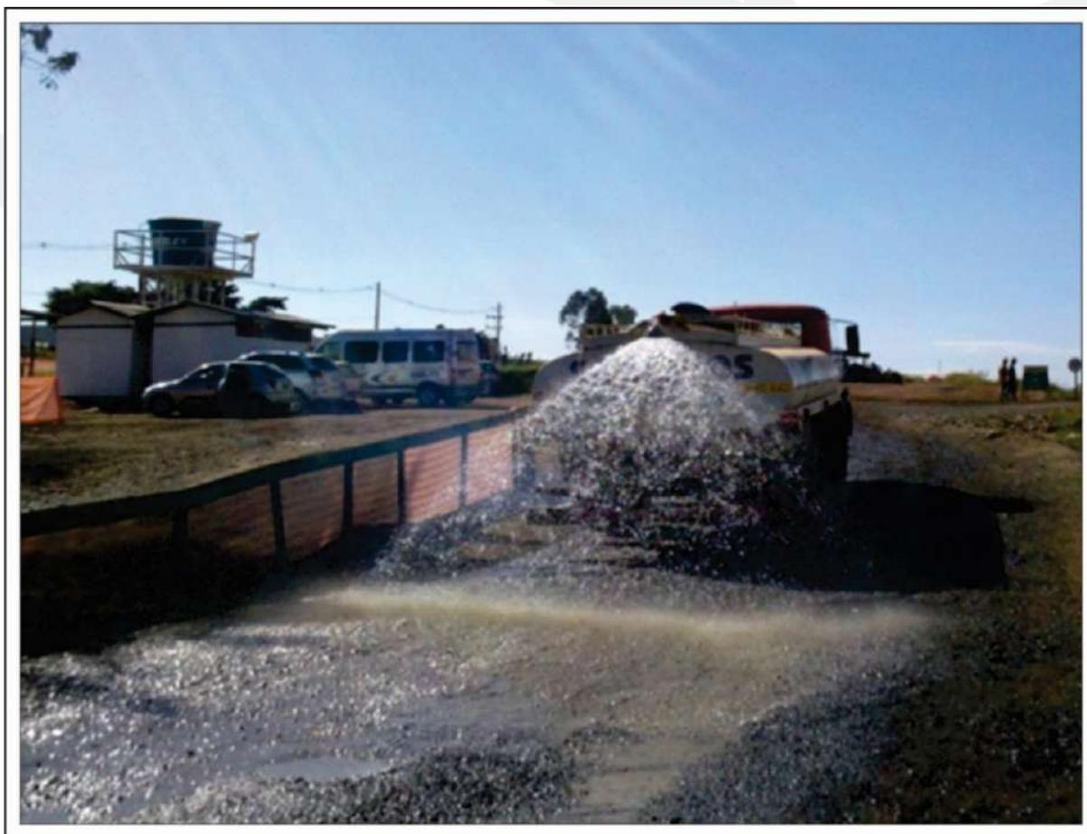
**Figura 14. Exemplo de umidificação de solo na obra.**
