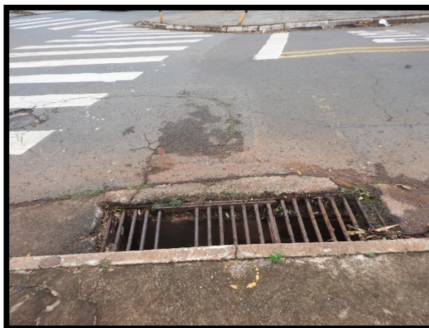
Foto 14: Boca de lobo localizada próximo ao futuro mall.
