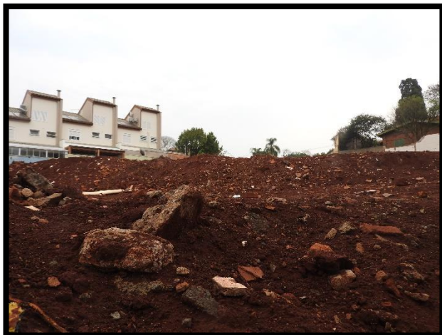
Foto 1: Vista para a área já sem as estruturas que existiam nas ocupações anteriores.
