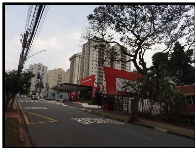
Foto 22: Fiação elétrica existente na R. Jasmim.
