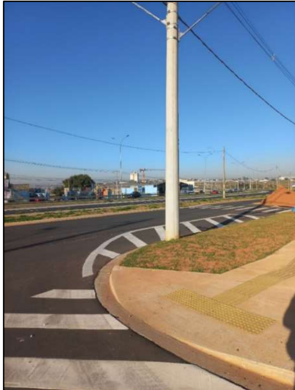
Foto 33. Rampa de acesso à Quadra H2 (ADA).
