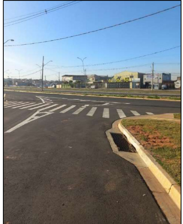
Foto 34. Sinalização na Avenida 3.
