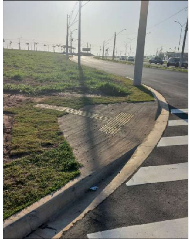
Foto 30. Rampa de acesso à Quadra H2.
