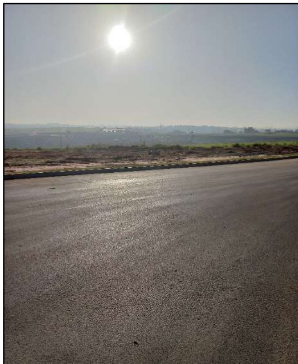
Foto 44. Sistema viário interno do loteamento.
