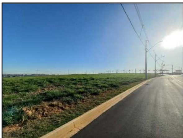
Foto 27. Pavimentação da Quadra H2.
