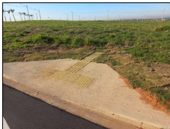
Foto 28. Rampa de acesso à Quadra H2.
