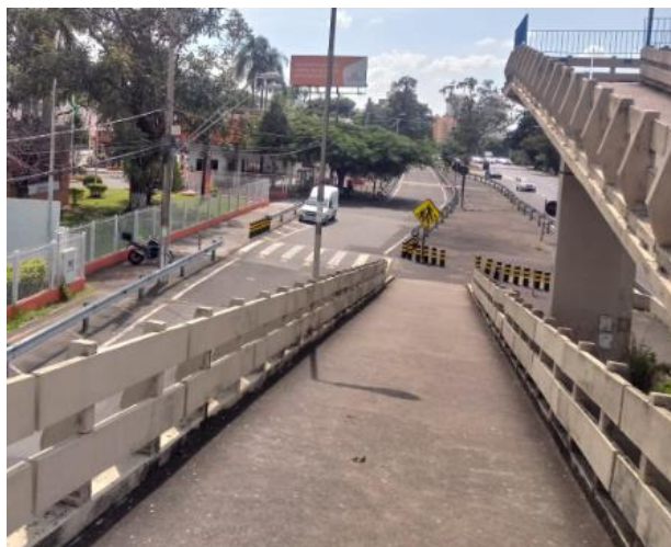
PASSARELA PARA TRAVESSIA DA RODOVIA
