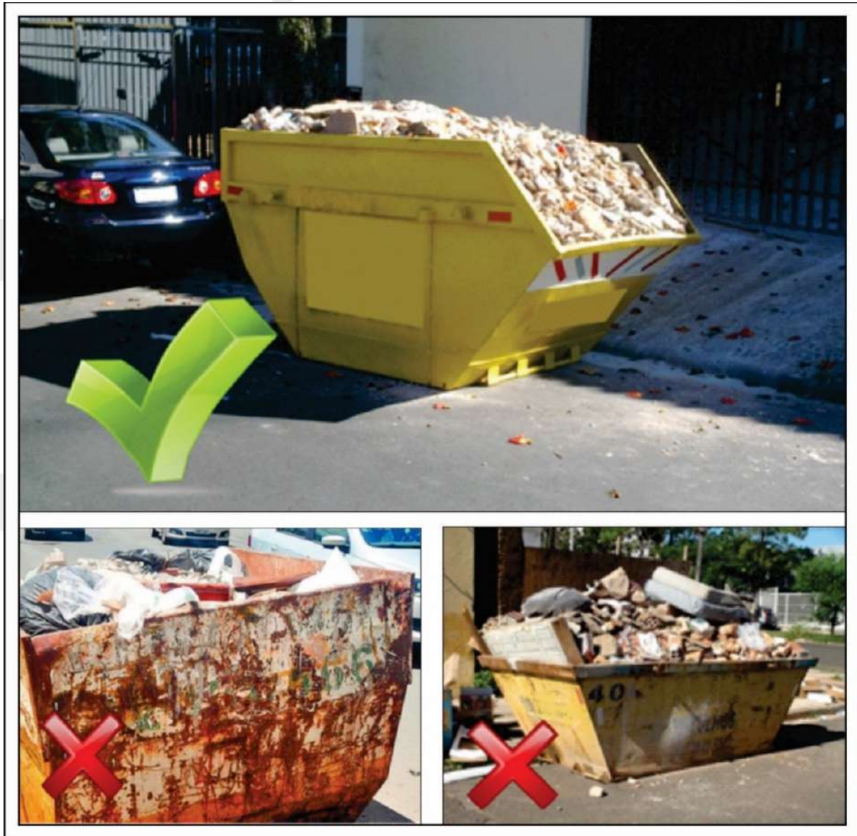
Figura 17. Modelo de acondicionamento de resíduos em caçambas
