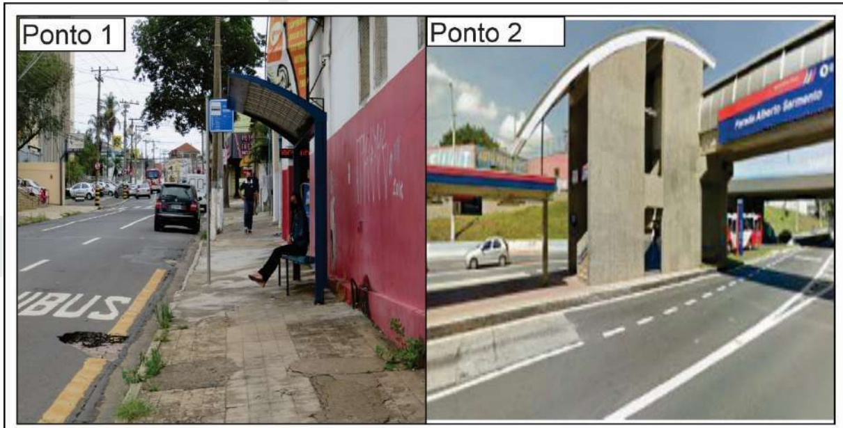
Figura 29. Condições dos pontos de parada de ônibus localizados Elaborado por Global Vias
