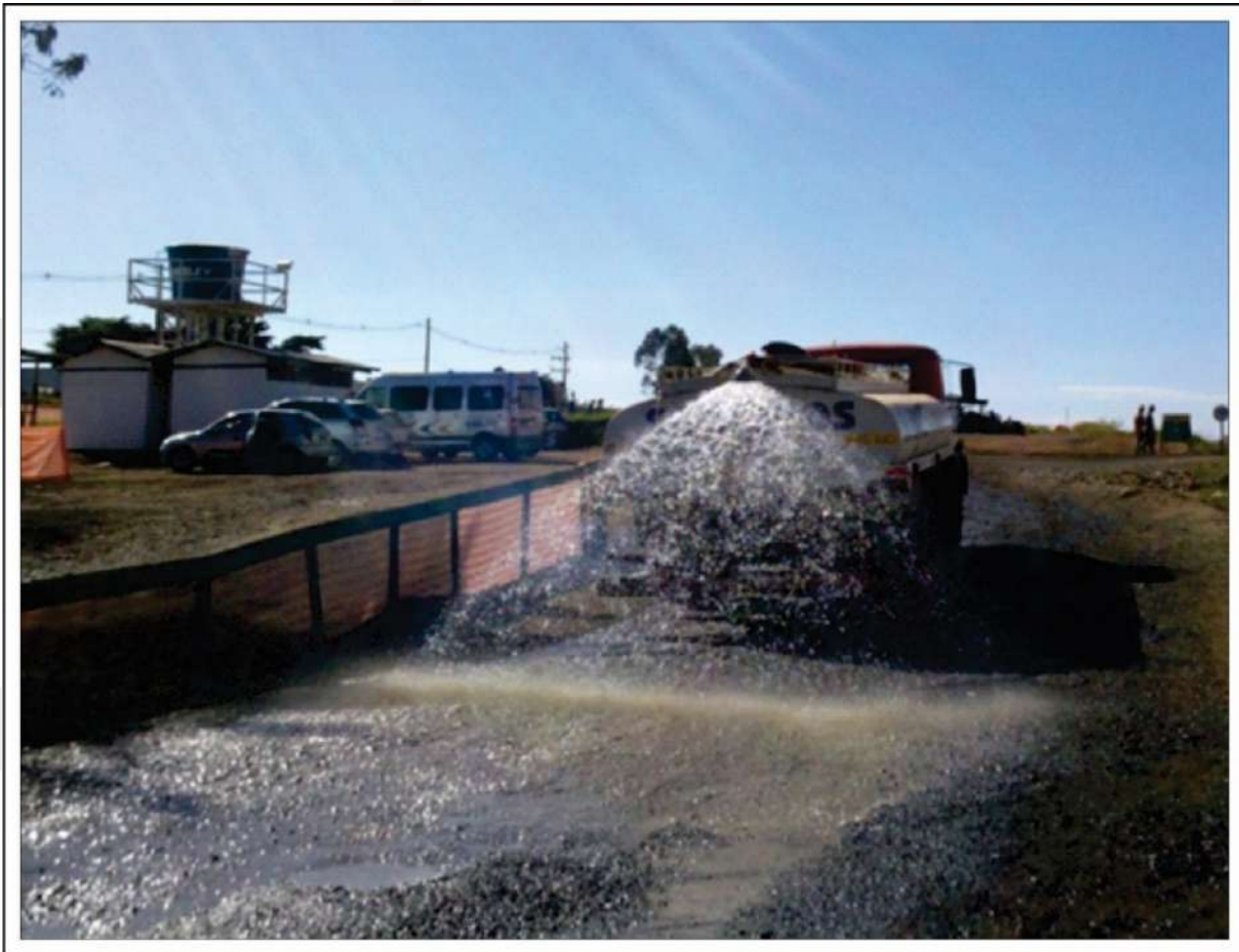
Figura 13. Exemplo de umidificação de solo na obra. Fonte: Global Vias
